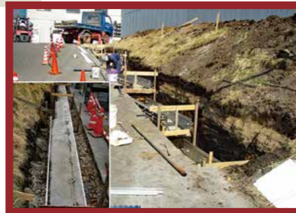
基礎コンクリートの施工
