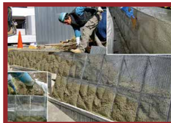
コンクリートの打設
