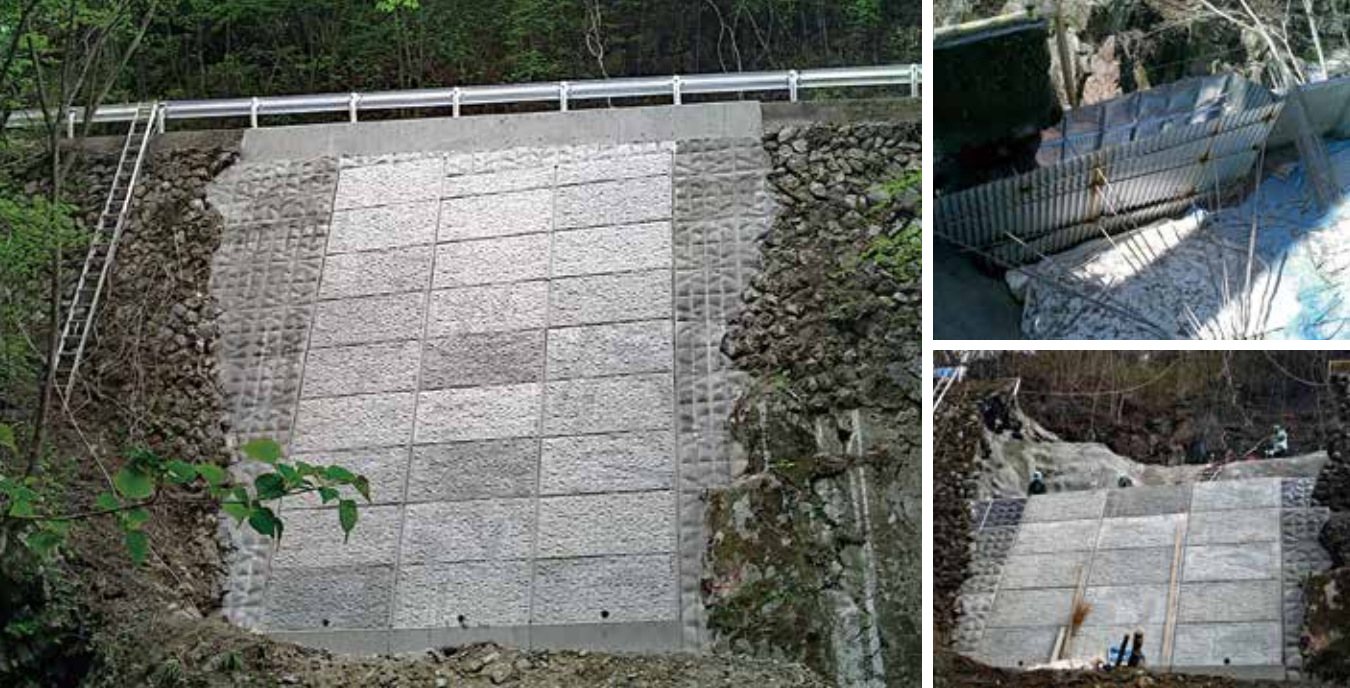
施工完了状況
