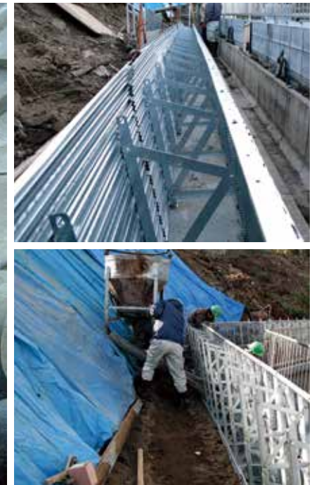
<上>デコメッシュ置くだけタイプ設置状況 <下>コンクリート打設状況
