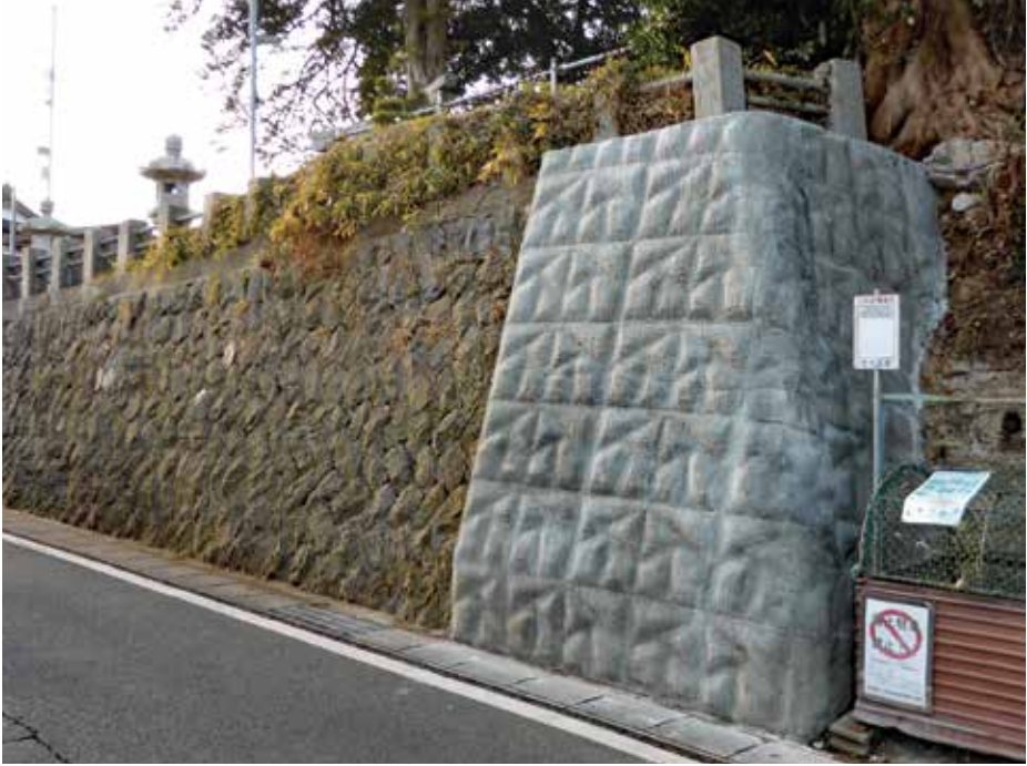
施工完了状況
