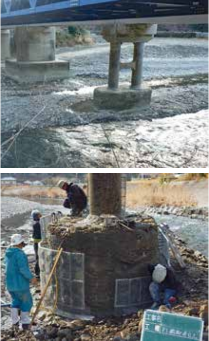
<上>施工前状況 <下>組立状況
