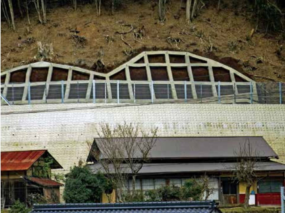
施工完了状況
