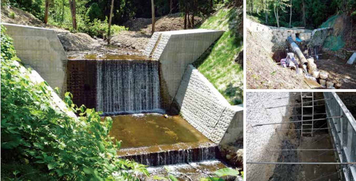
施工後2年状況
