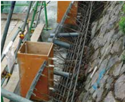
<上>傾斜部施工前状況 <下>組立状況(箱抜き加工)
