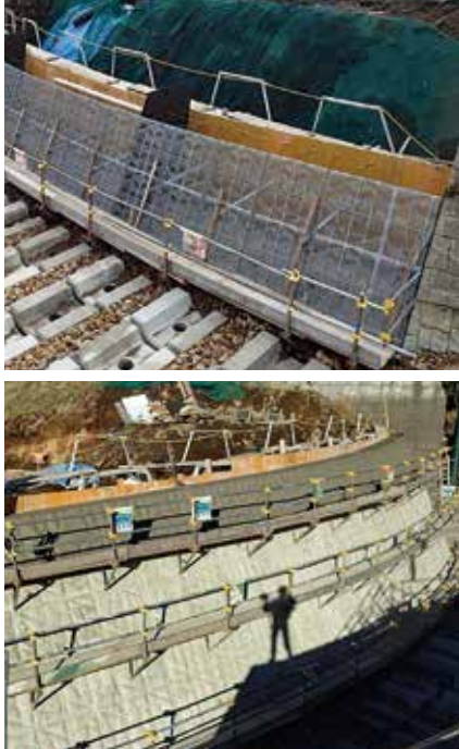
＜上＞組立完了状況 ＜下＞コンクリート打設完了状況
