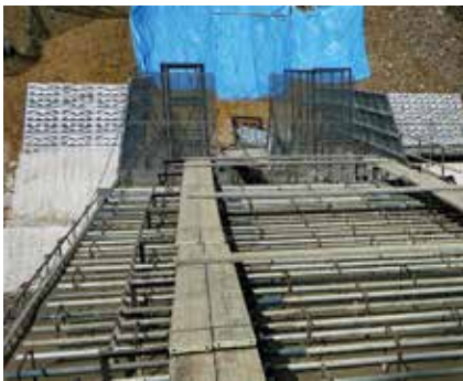
<上>間詰工施工状況 <下>足場工設置状況
