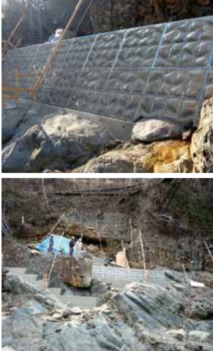
<上>組立状況 (近景) <下>組立状況 (遠景)
