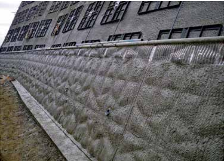
コンクリート打設状況
