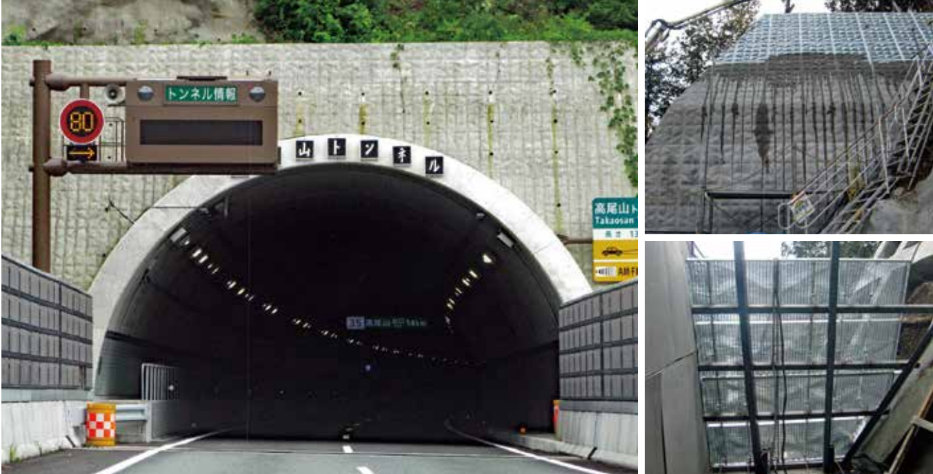
施工完了状況
