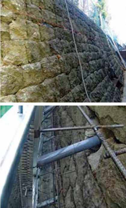
<上>施工前状況 <下>組立状況
