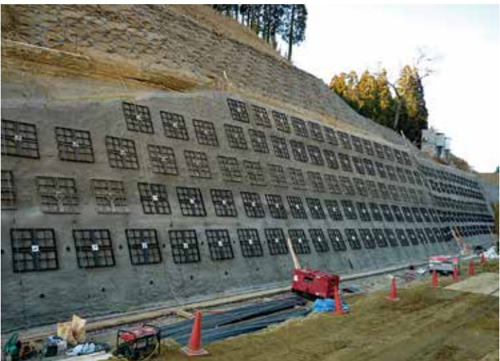
切土補強土工完了状況
