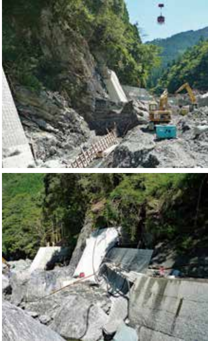
＜上＞索道によるコンクリート打設状況 ＜下＞組立状況
