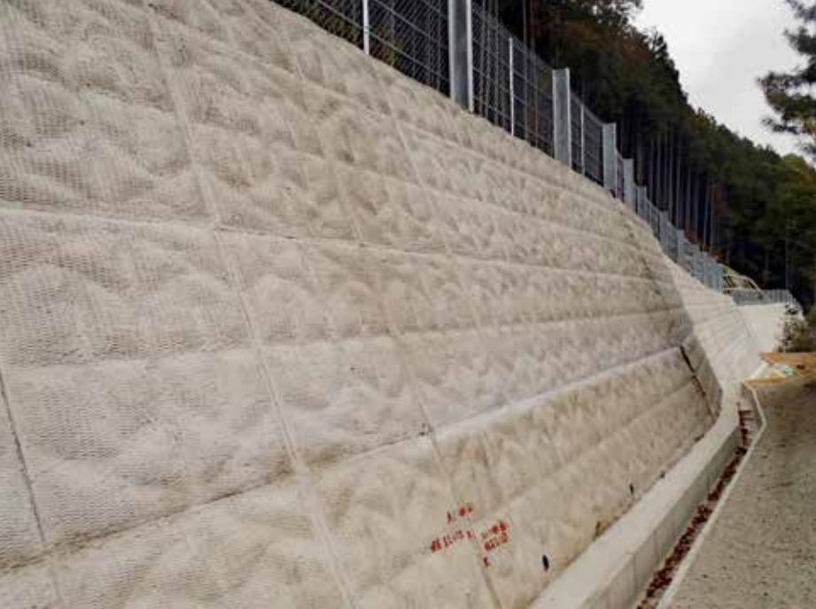
施工完了状況
