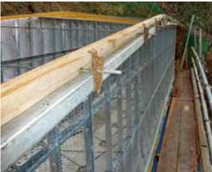
<上>切断加工状況 <下>天端加工状況
