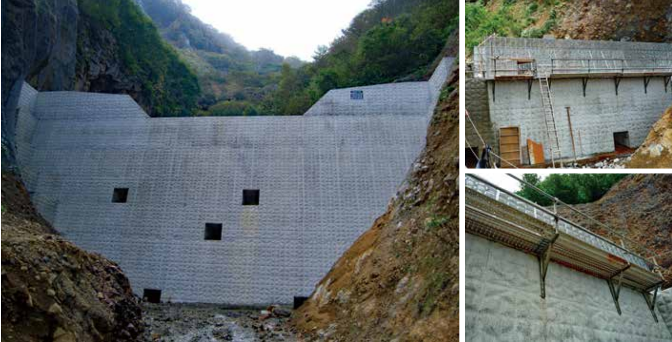
施工完了状況 <上>施工状況 <下>簡易足場設置状況
