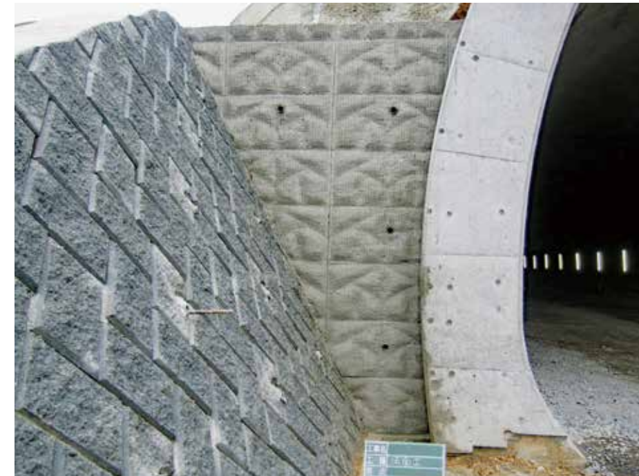
施工完了状況
