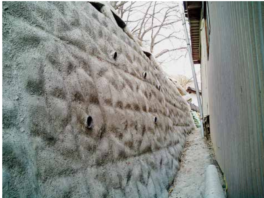
施工完了状況
