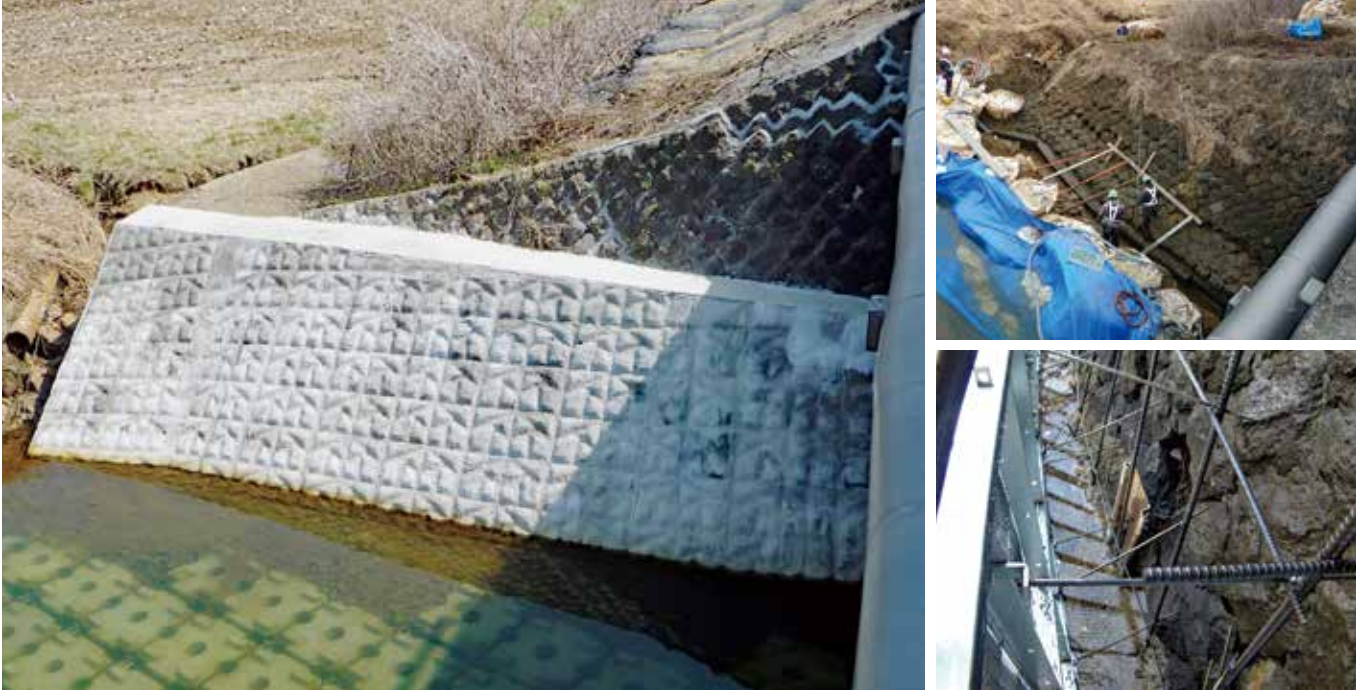
施工完了状況
