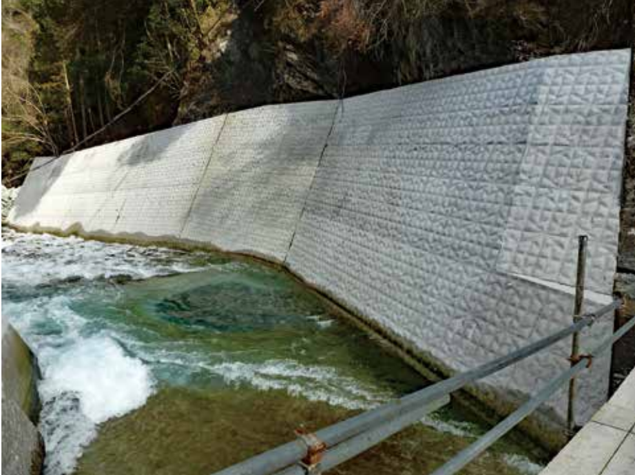
施工完了状況
