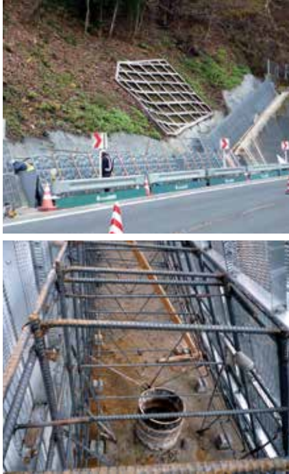
<上>組立状況 (遠景) <下>組立状況 (近景)
