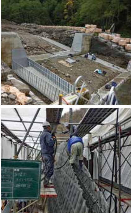
＜上＞施工当初状況 ＜下＞寒中コンクリート打設状況
