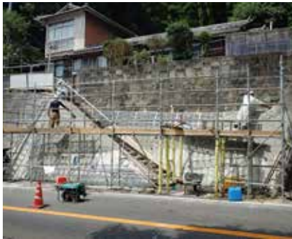
<上>施工前状況 <下>施工状況
