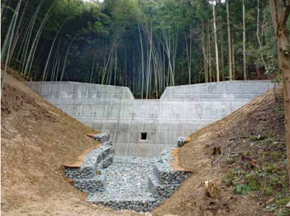
施工完了状況
