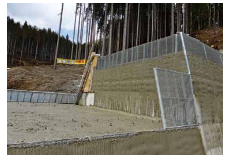
コンクリート打設状況
