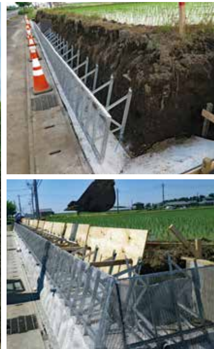
<上>デコメッシュ置くだけタイプ設置状況 <下>施工状況
