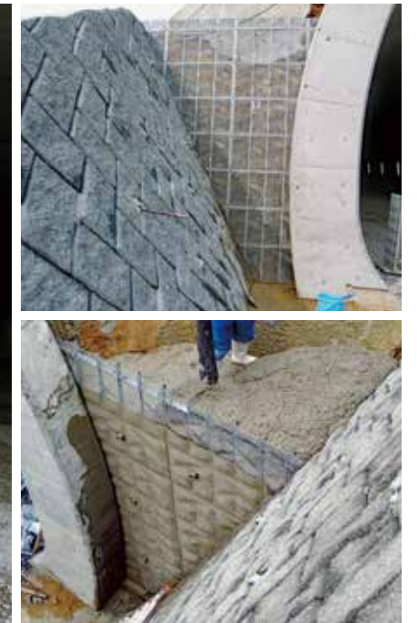
<上>組立完了状況 <下>コンクリート打設状況
