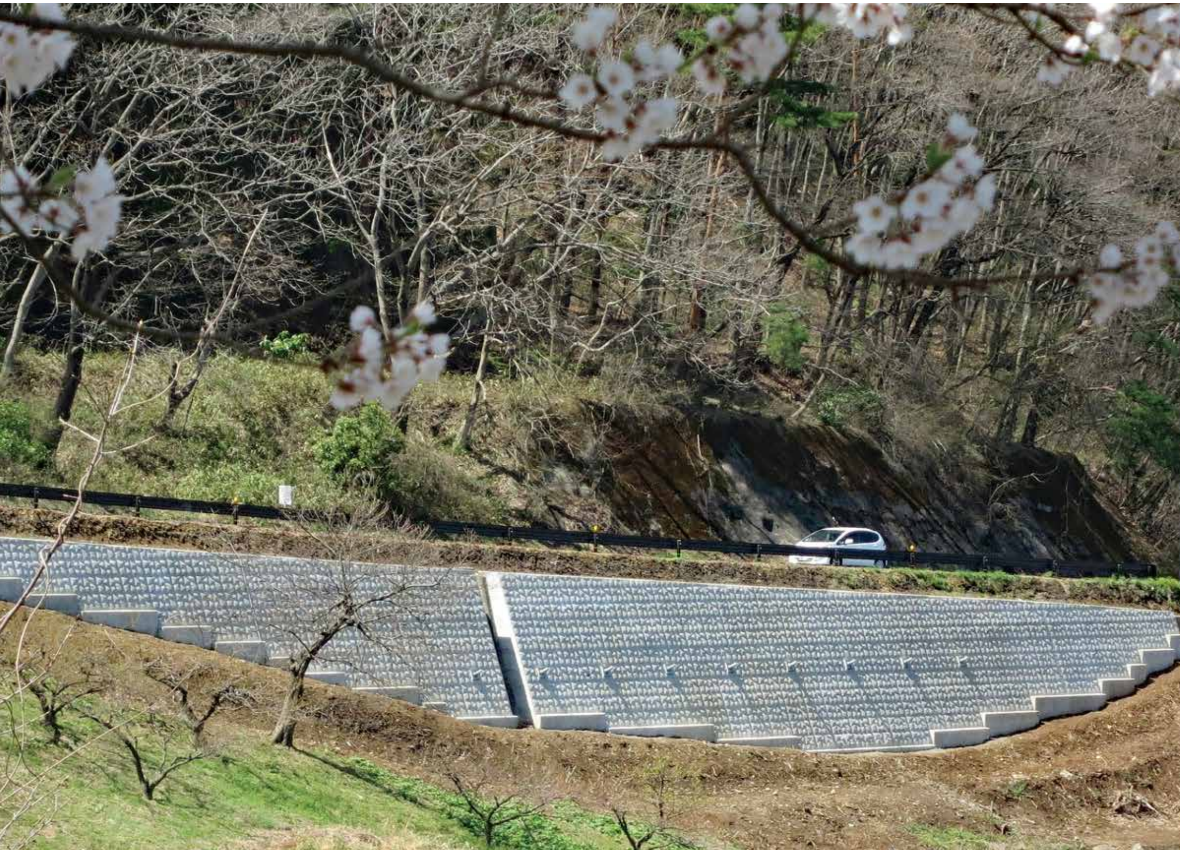
施工完了状況
