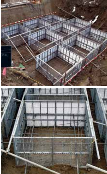
<上>組立完了状況(遠景) <下>組立完了状況(近景)
