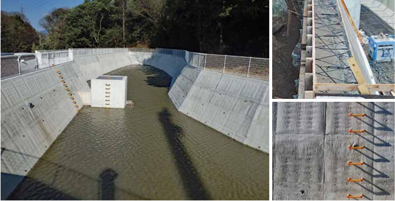
施工完了状況 <上>普通型枠との組合せ施工前状況 <下>昇降階段設置状況
