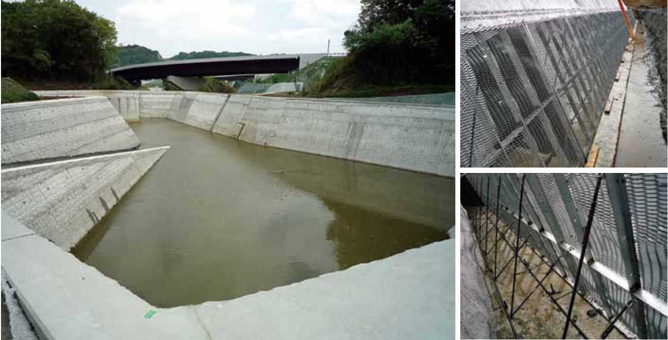
施工完了状況 <上>組立状況(前面) <下>組立状況(背面)
