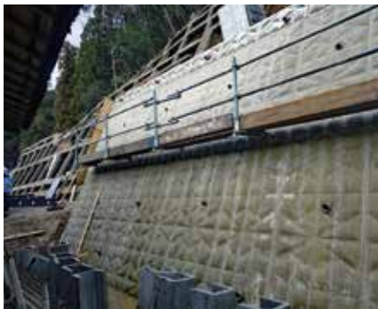
<上>裏込め砕石同時施工状況 <下>足場設置状況
