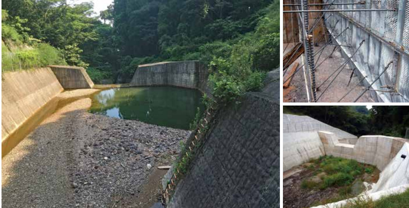
施工後7年状況 <上>折り曲げ加工状況 <下>施工完了状況
