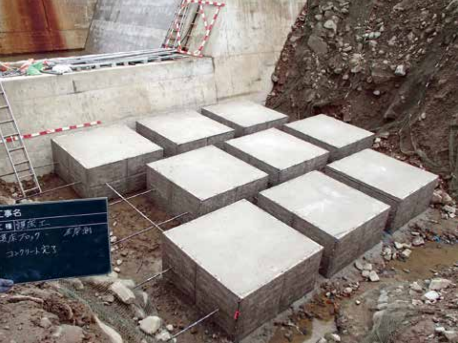
施工完了状況
