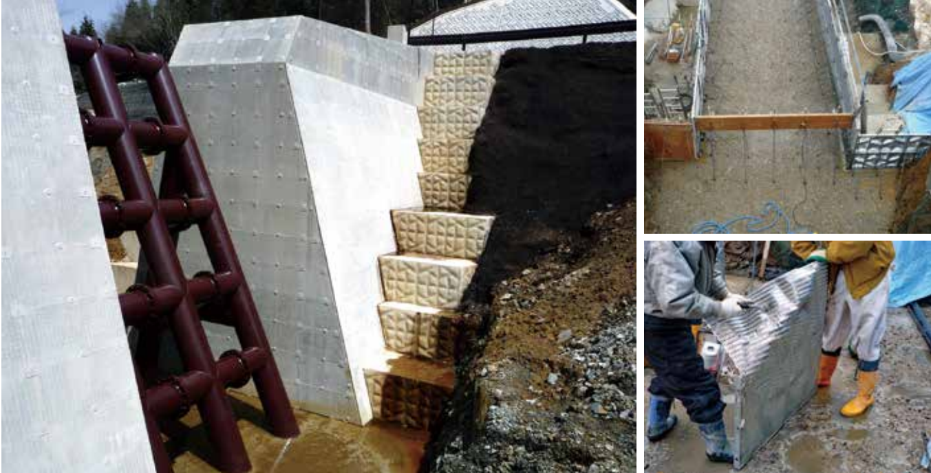
施工完了状況
