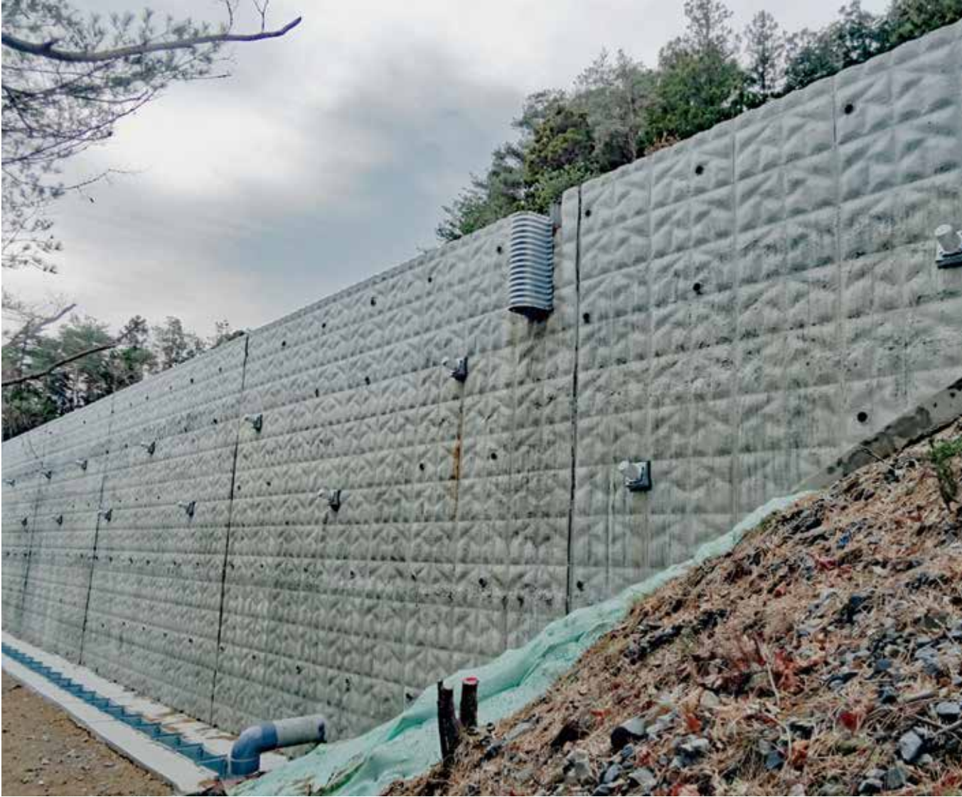
施工完了状況
