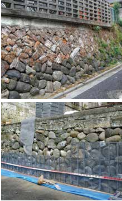
<上>施工前状況 <下>組立状況
