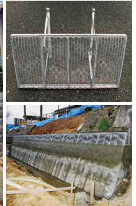
<上>デコメッシュ置くだけタイプ <下>施工状況
