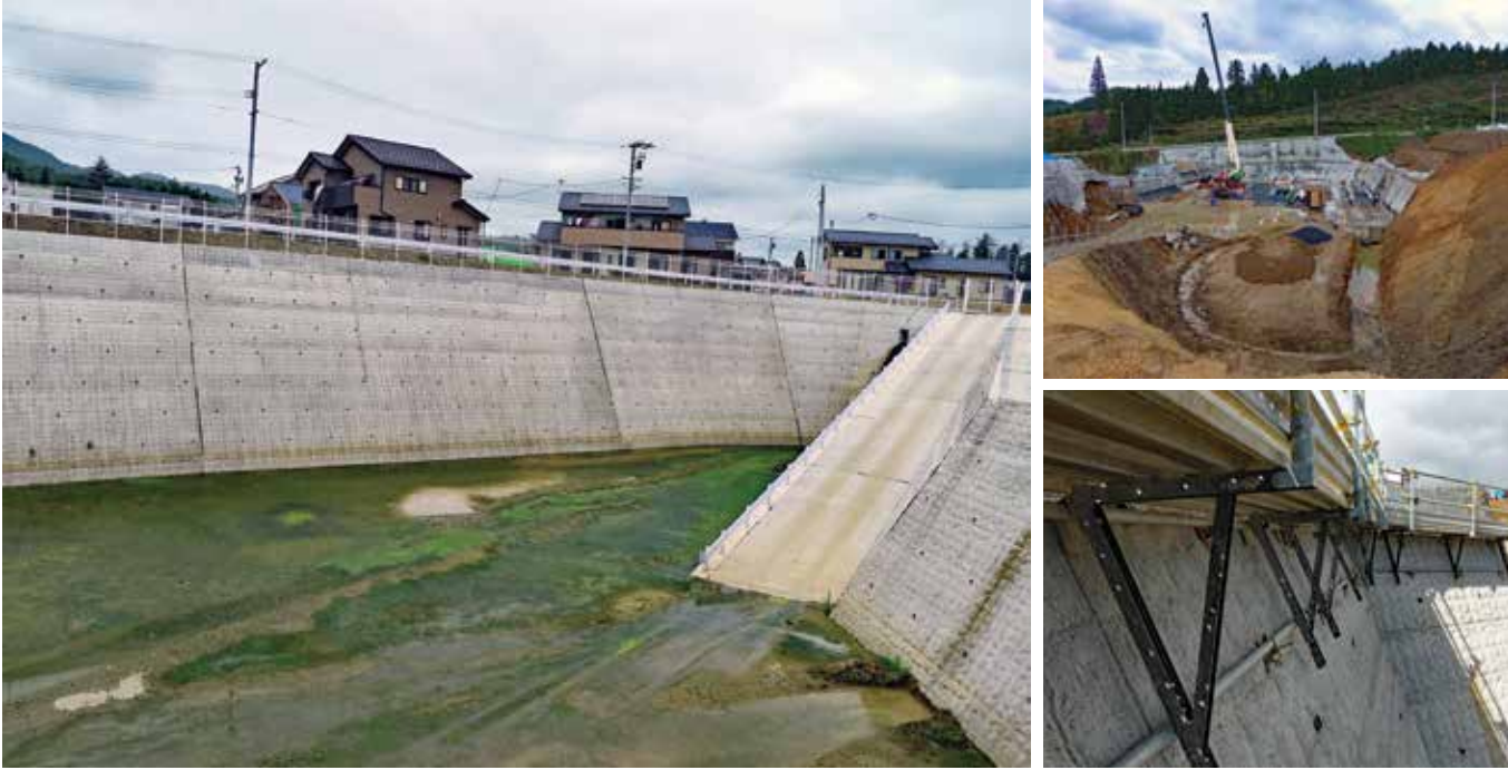
施工完了状況 <上>施工前状況 <下>簡易足場設置状況
