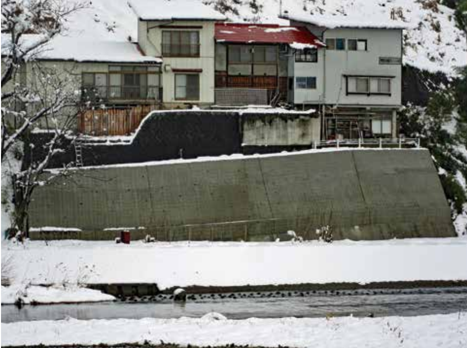
施工完了状況
