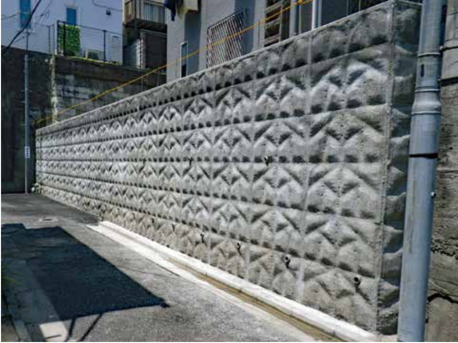
施工完了状況
