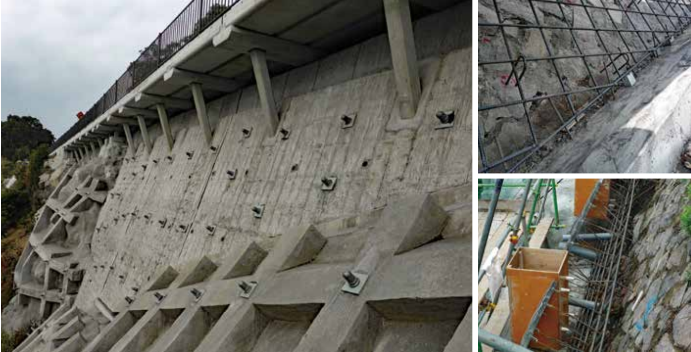
施工完了状況
