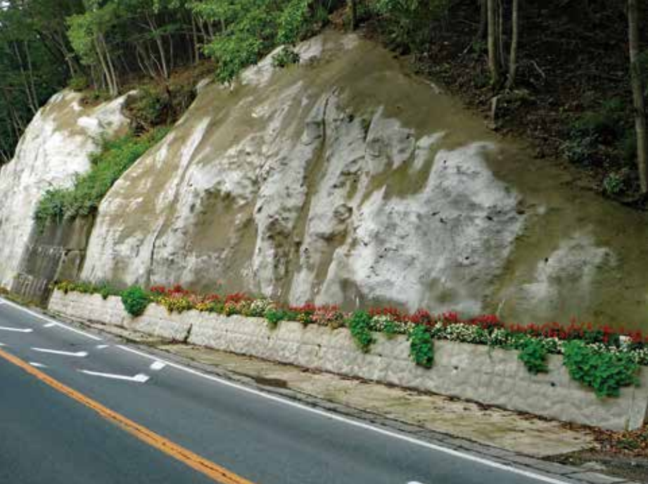
施工完了状況
