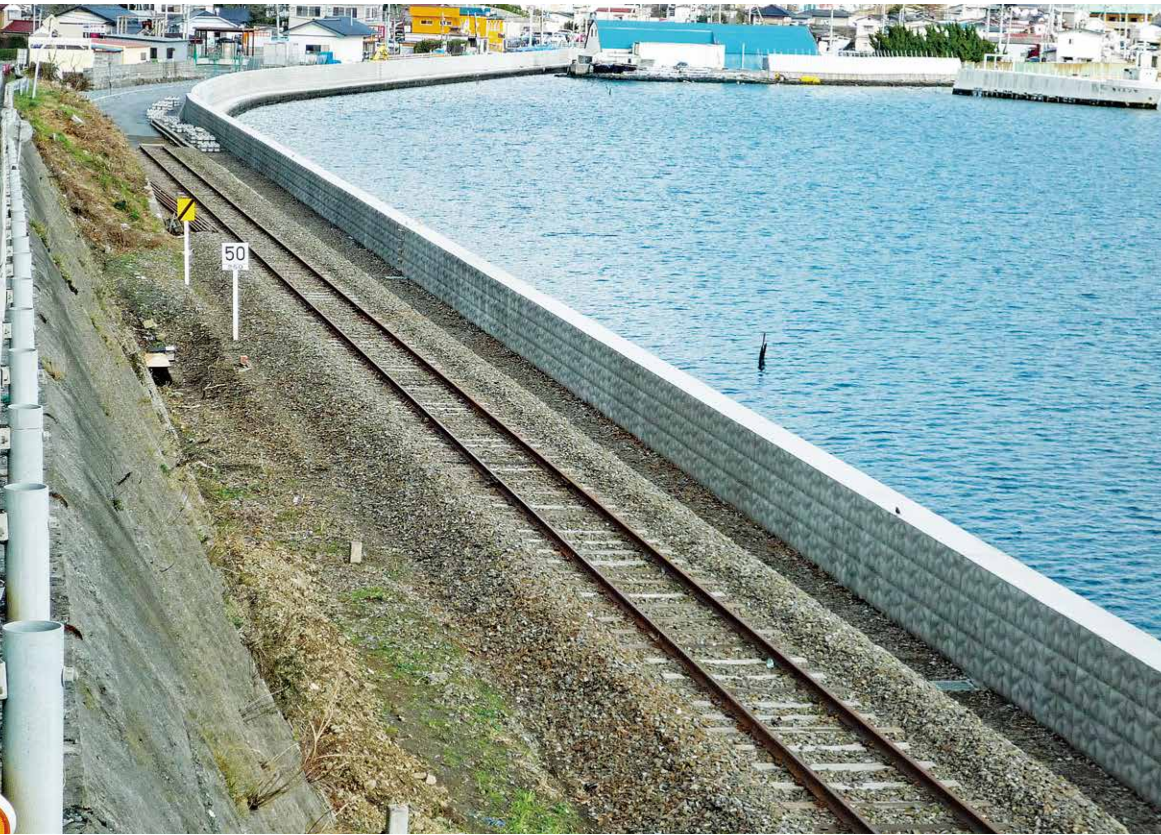
施工完了状況
