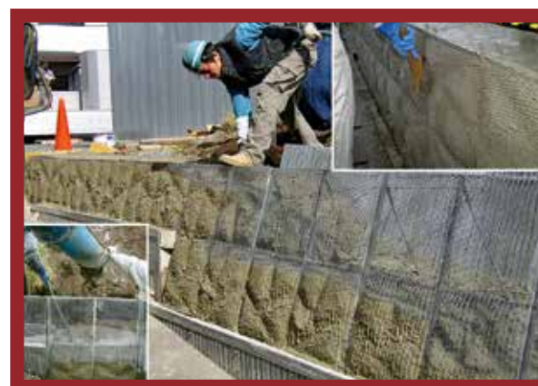
コンクリートの打設
