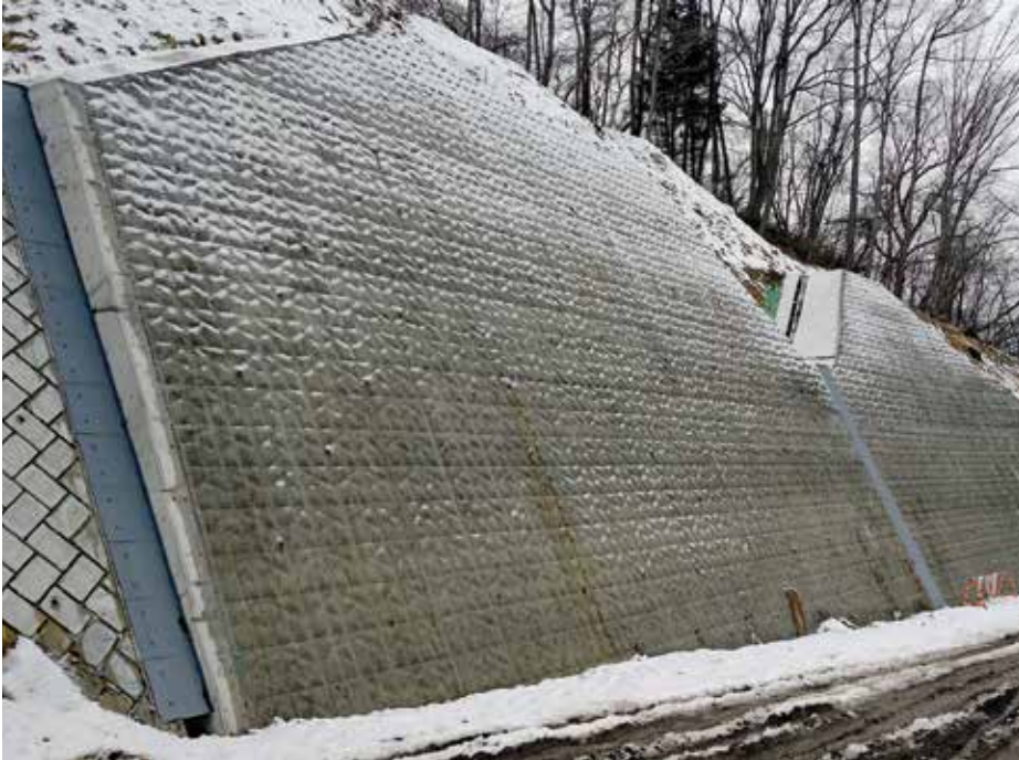
施工完了状況
