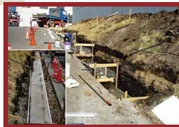
基礎コンクリートの施工
