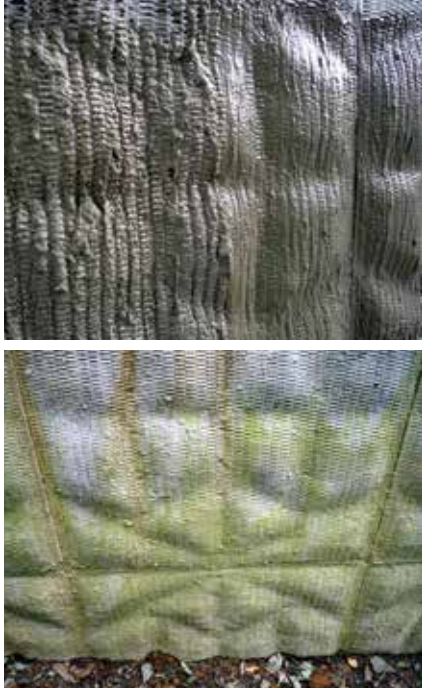
<上>刷毛仕上げ状況 (左:前。右:後) <下>施工後4ヶ月で苔が生育を始めた状況
