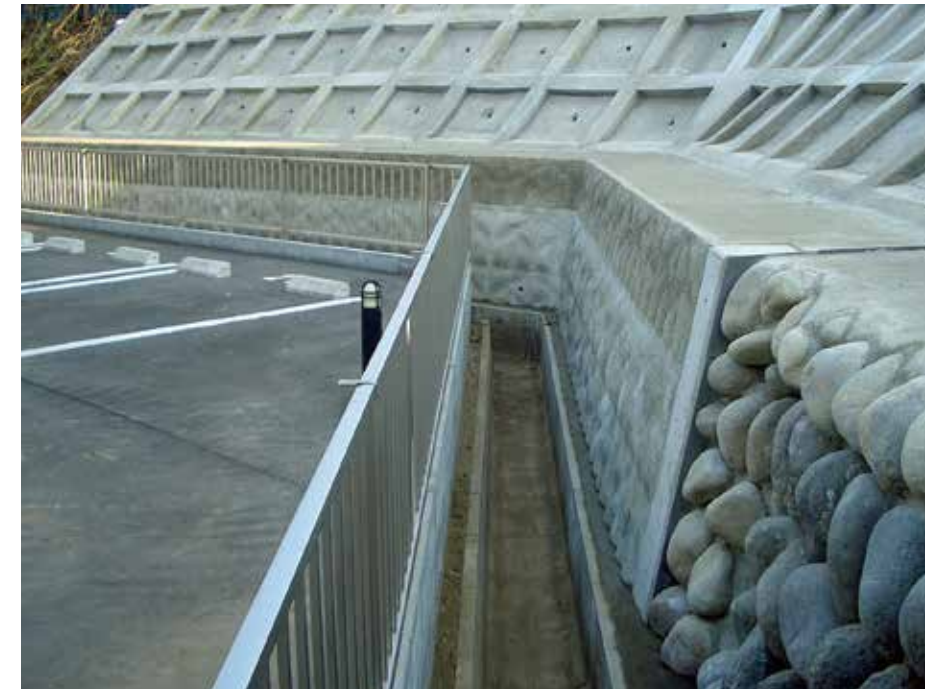
施工完了状況
