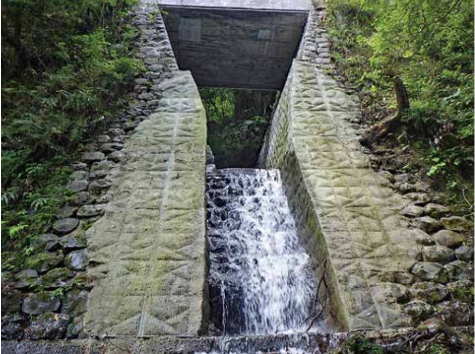
施工完了状況
