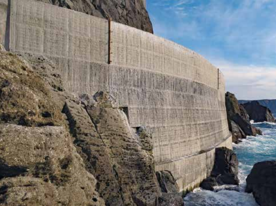
施工完了状況
