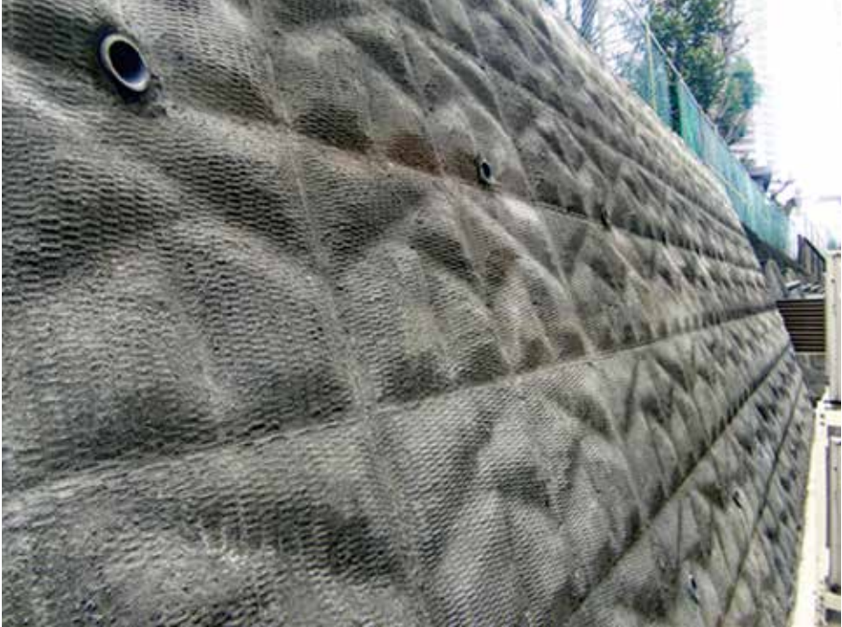
施工完了状況
