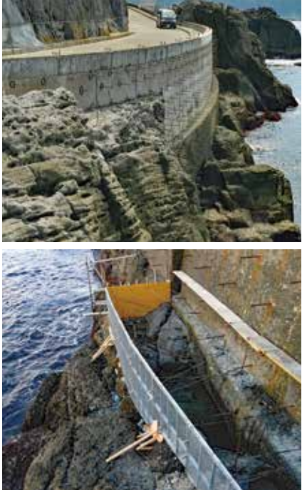
＜上＞施工前状況 ＜下＞施工状況
