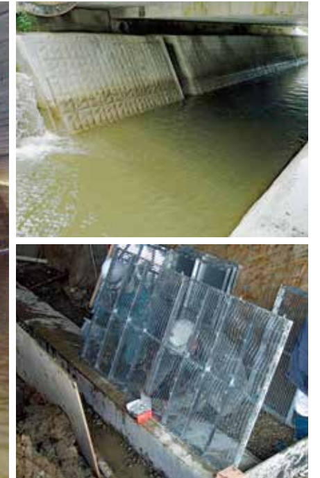
<上>施工後1年状況 <下>組立状況
