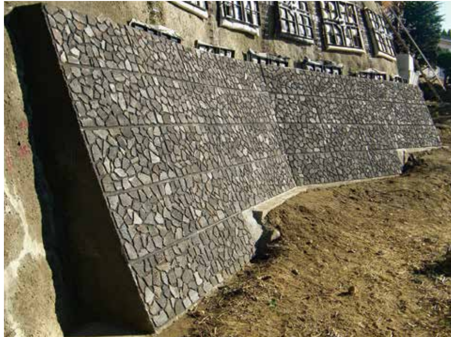
施工完了状況
