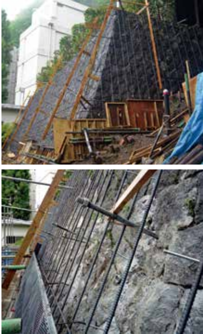
<上>配筋工、切土補強土工完了状況 <下>組立状況
