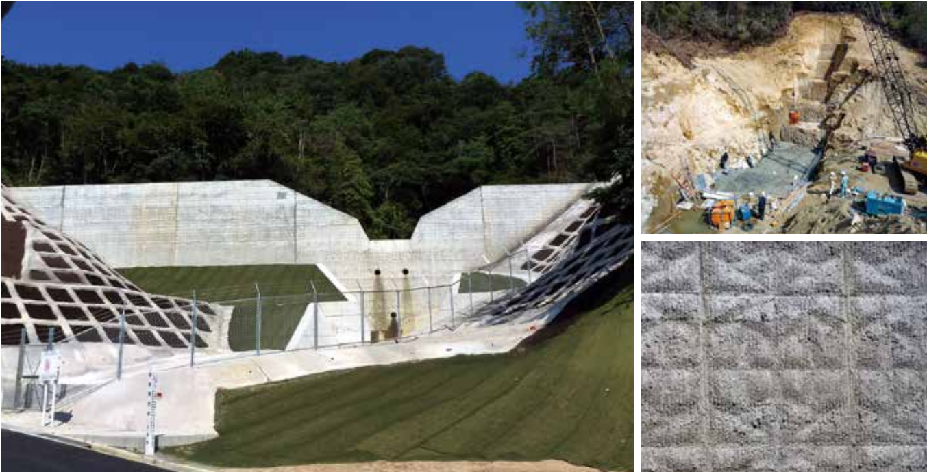
施工完了状況 <上>施工当初状況 <下>刷毛仕上げなしの表面状況
