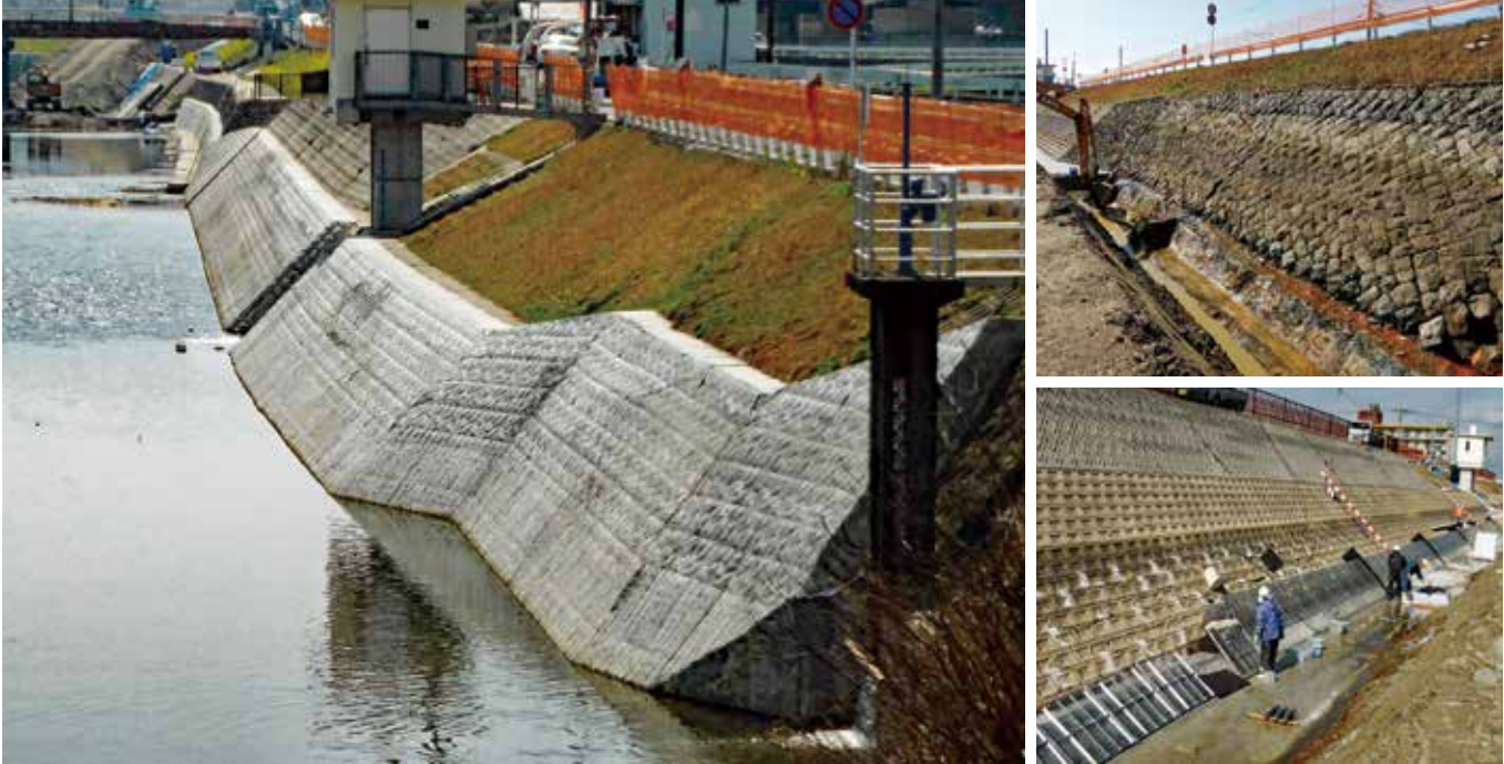
施工完了状況
