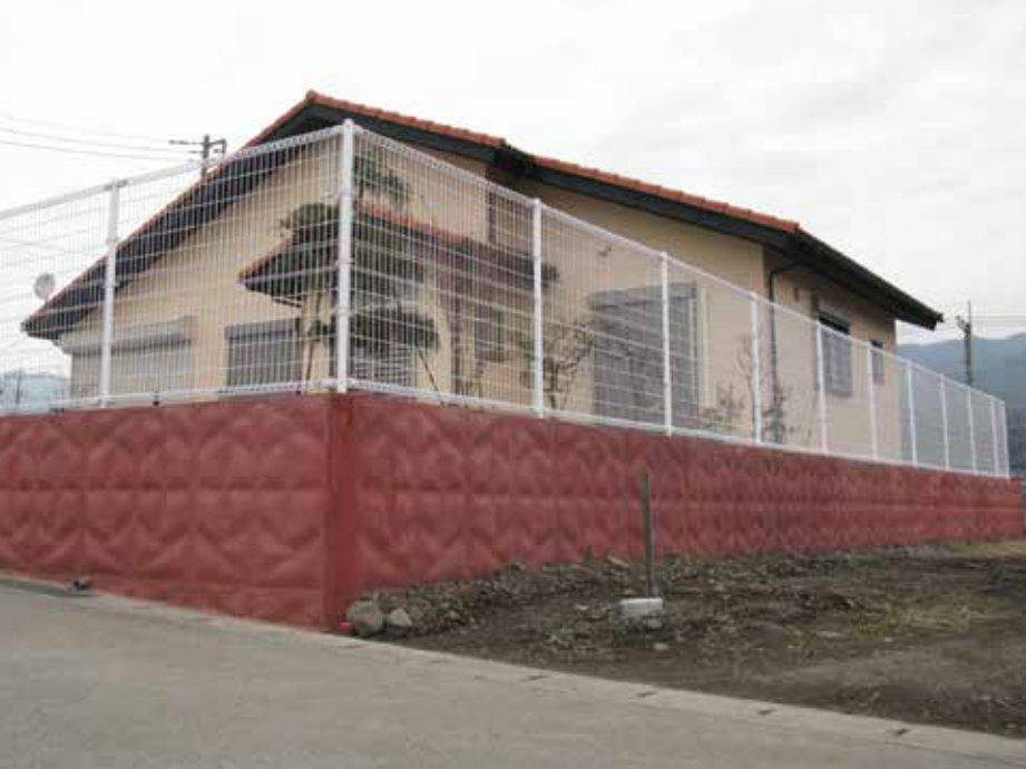
施工完了状況
