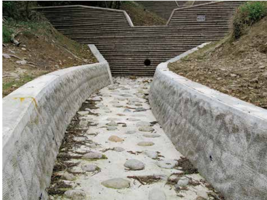
施工完了状況
