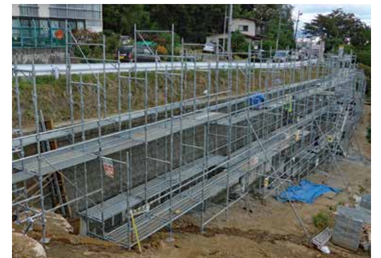
足場設置状況
