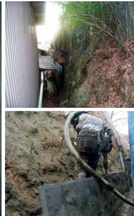
<上>施工前状況 <下>モルタル吹付状況
