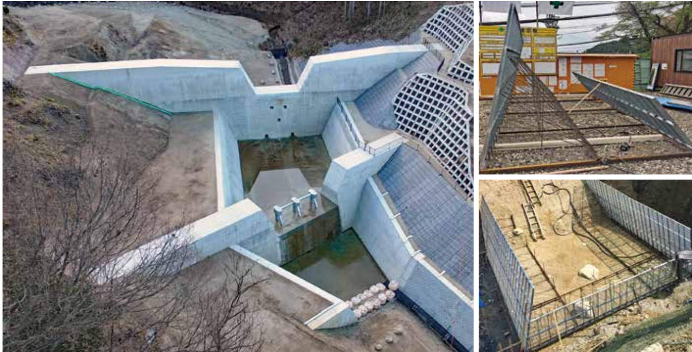
施工完了状況 <上>丘組状況 <下>丘組材現場設置状況
