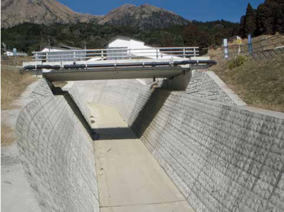
施工完了状況
