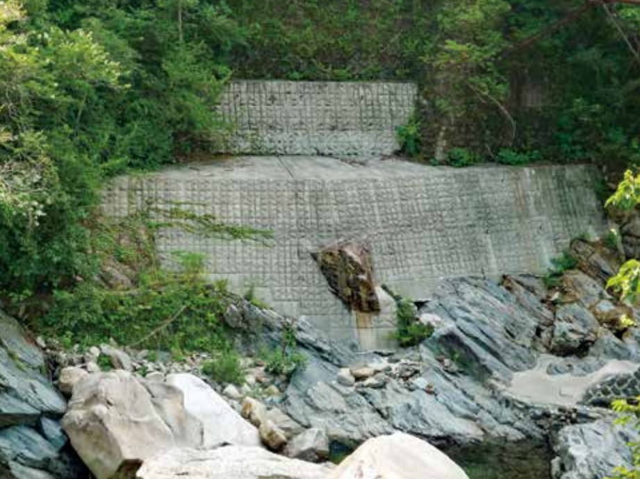
施工後3年状況
