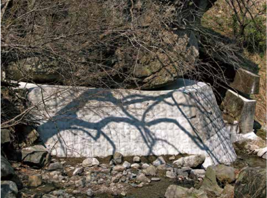
施工完了状況
