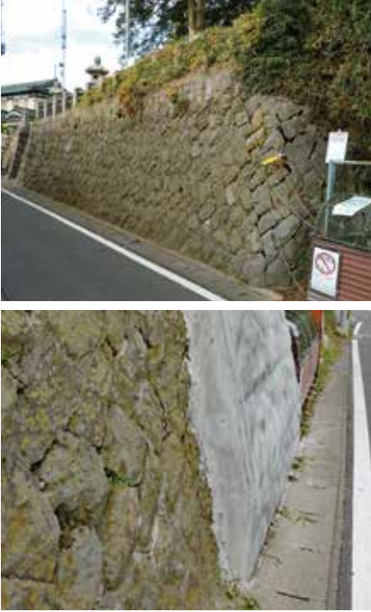
<上>施工前状況 <下>法尻部施工状況
