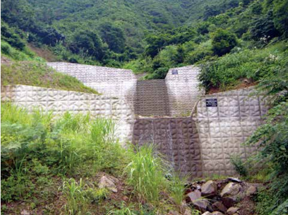
施工完了状況
