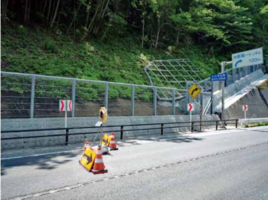
施工完了状況
