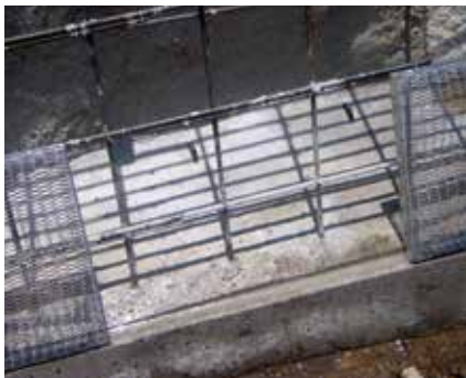
<上>組立状況 <下>配筋状況
