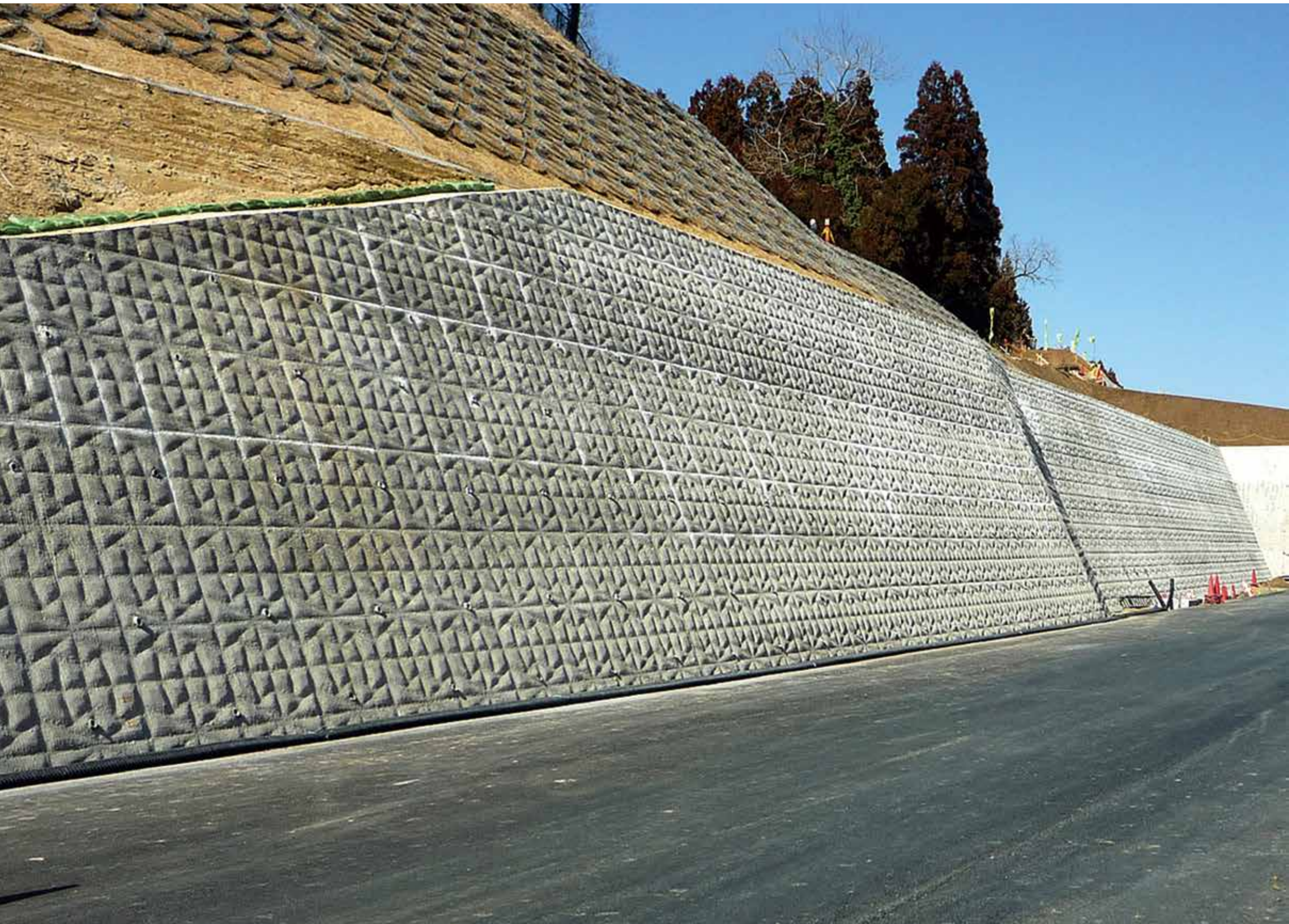
施工完了状況
