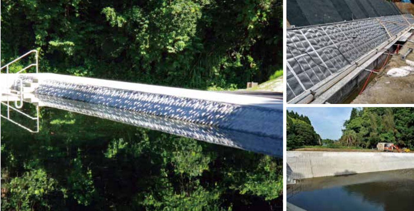
施工完了状況(満水時) <上>組立状況 <下>施工完了状況(満水時)
