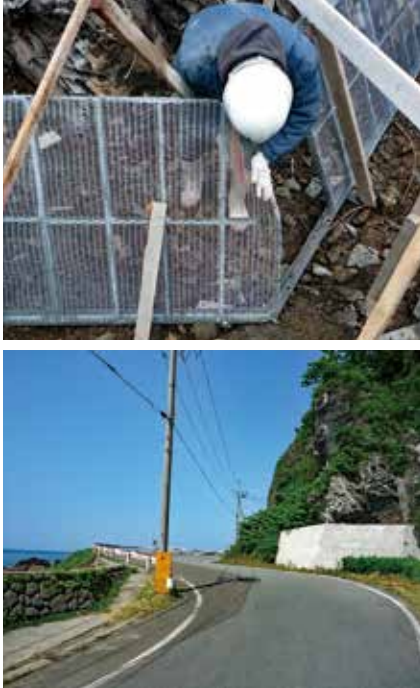
<上>折れ点の加工状況 <下>施工完了状況
