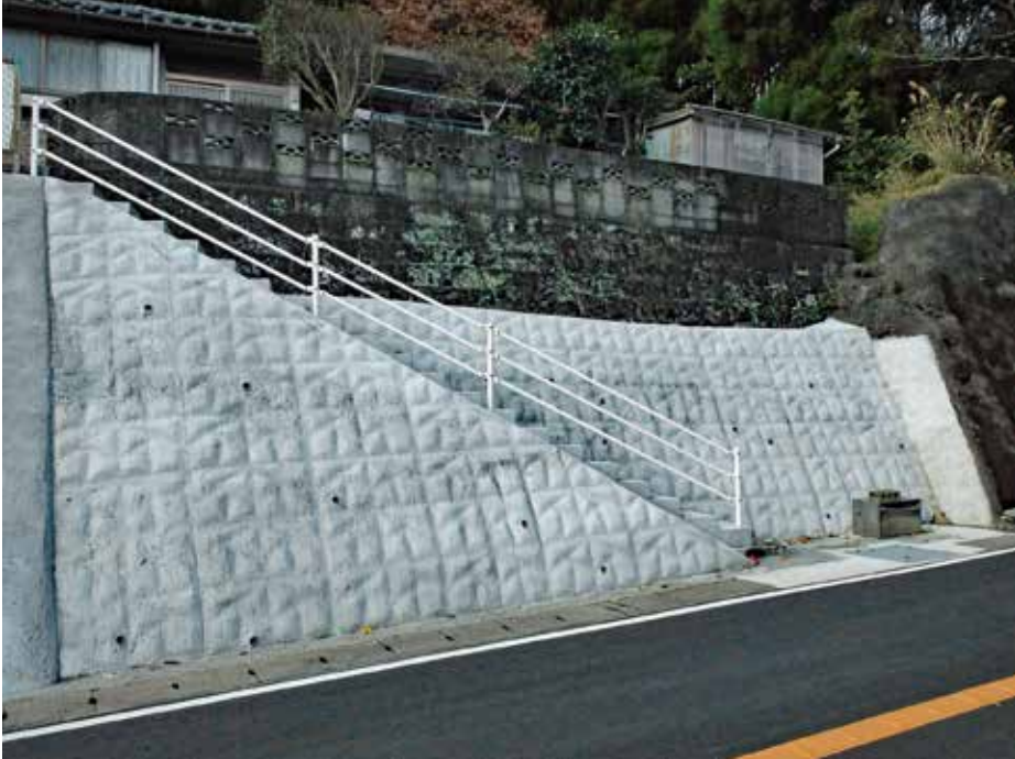
施工完了状況
