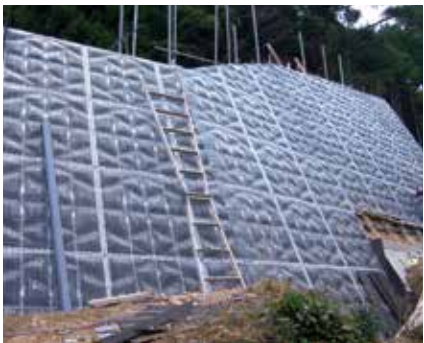
<上>コンクリート打設状況 <下>組立完了状況
