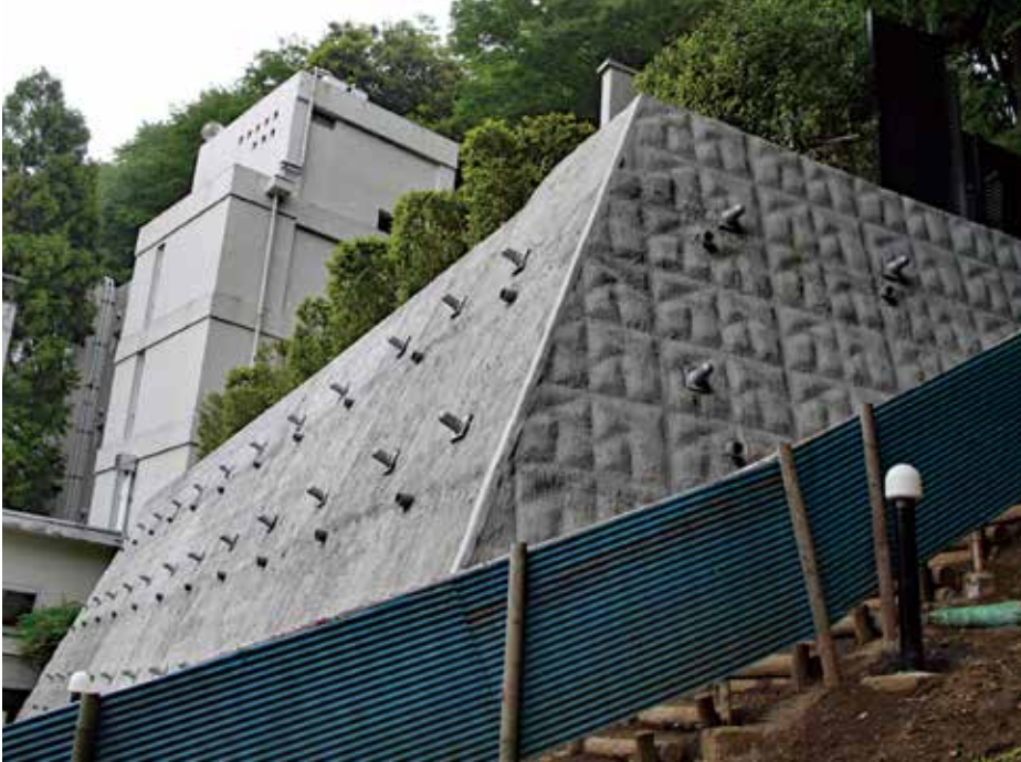
施工完了状況
