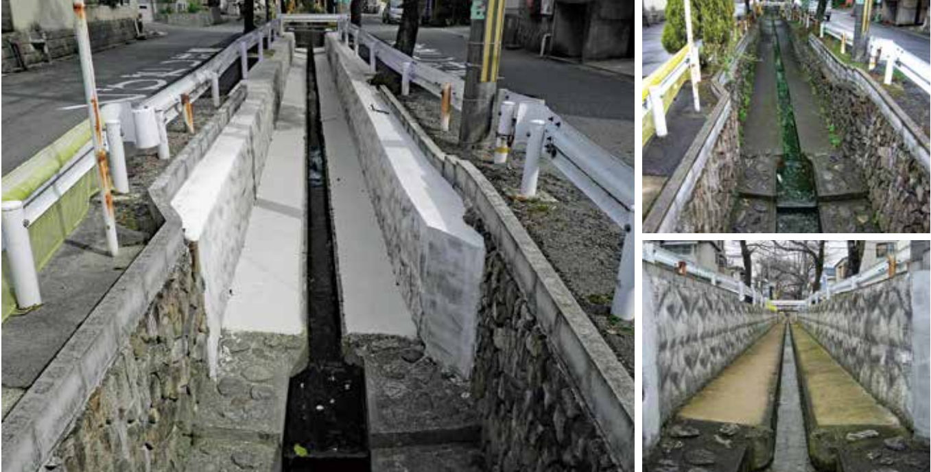
施工完了状況
