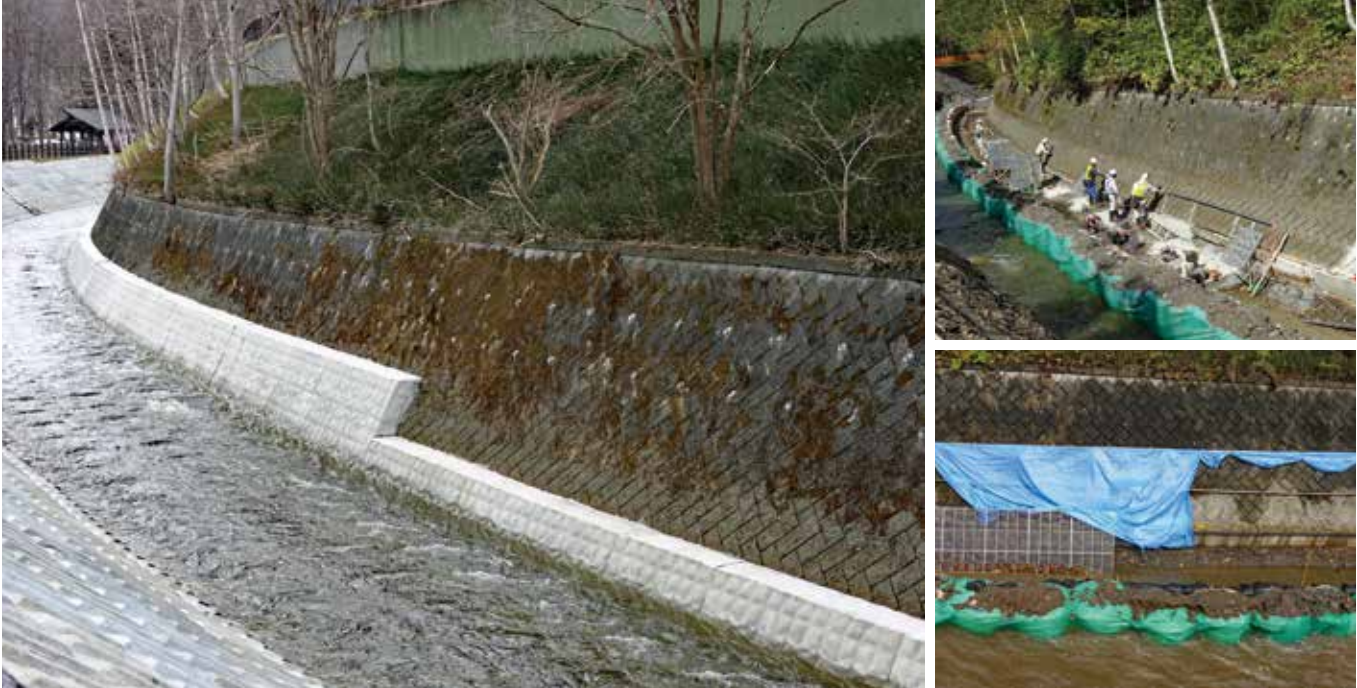
施工完了状況
