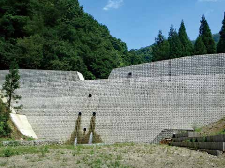
施工完了状況
