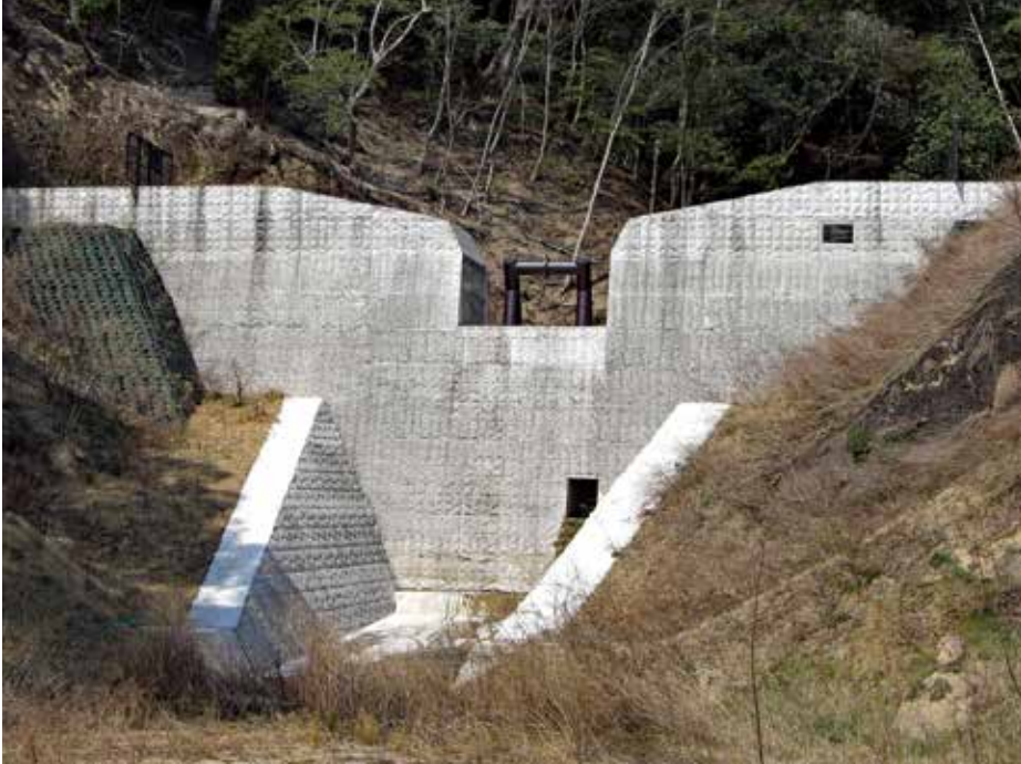
施工完了状況
