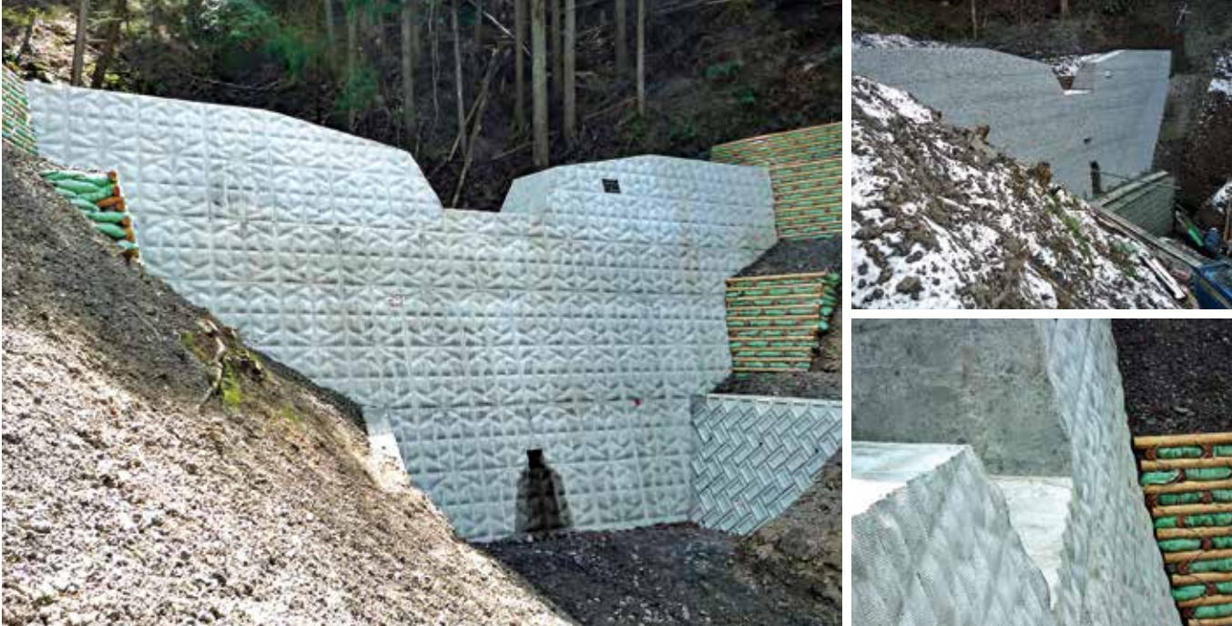
施工完了状況
