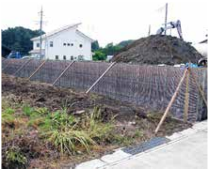
<上>配筋状況 <下>組立完了状況
