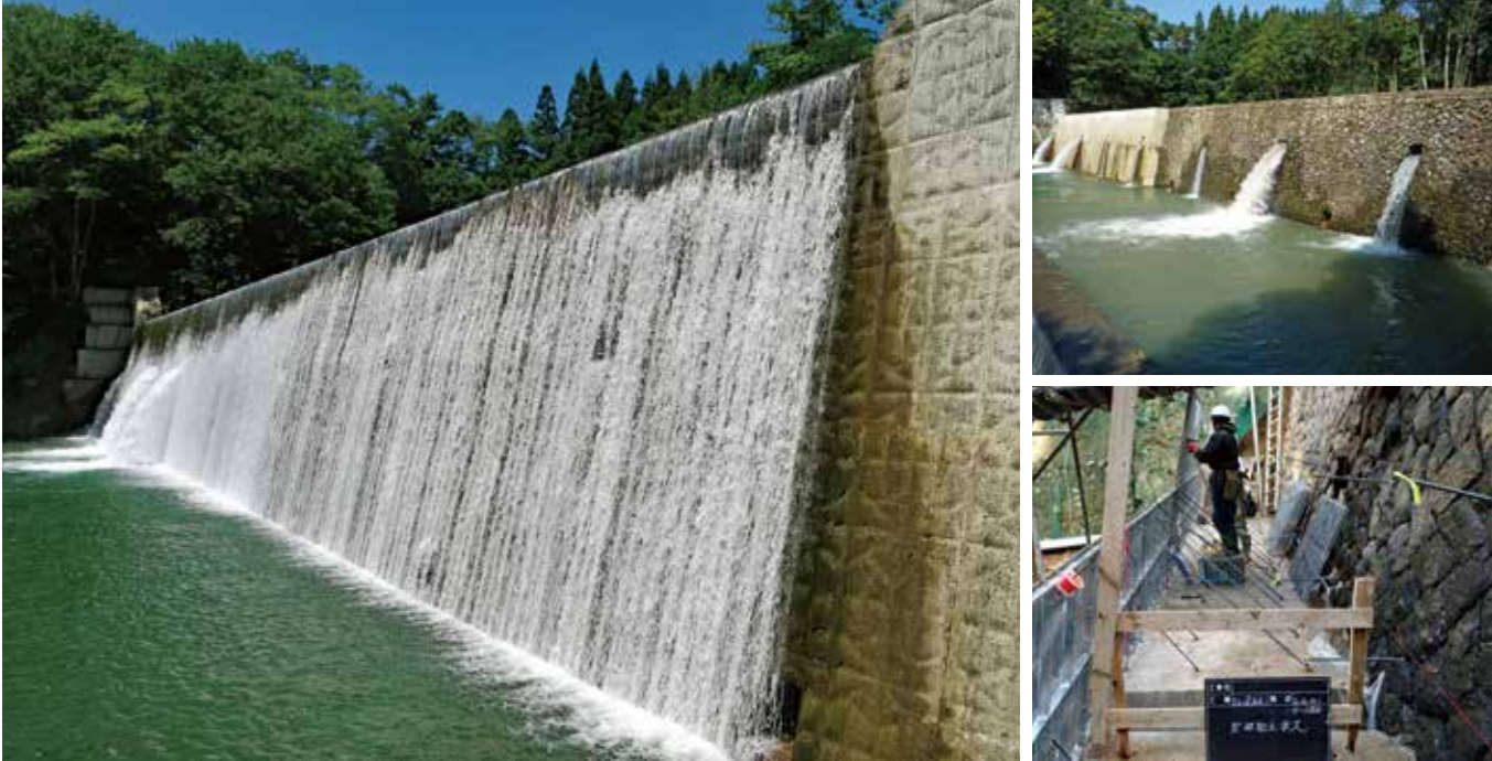
施工後3年状況
