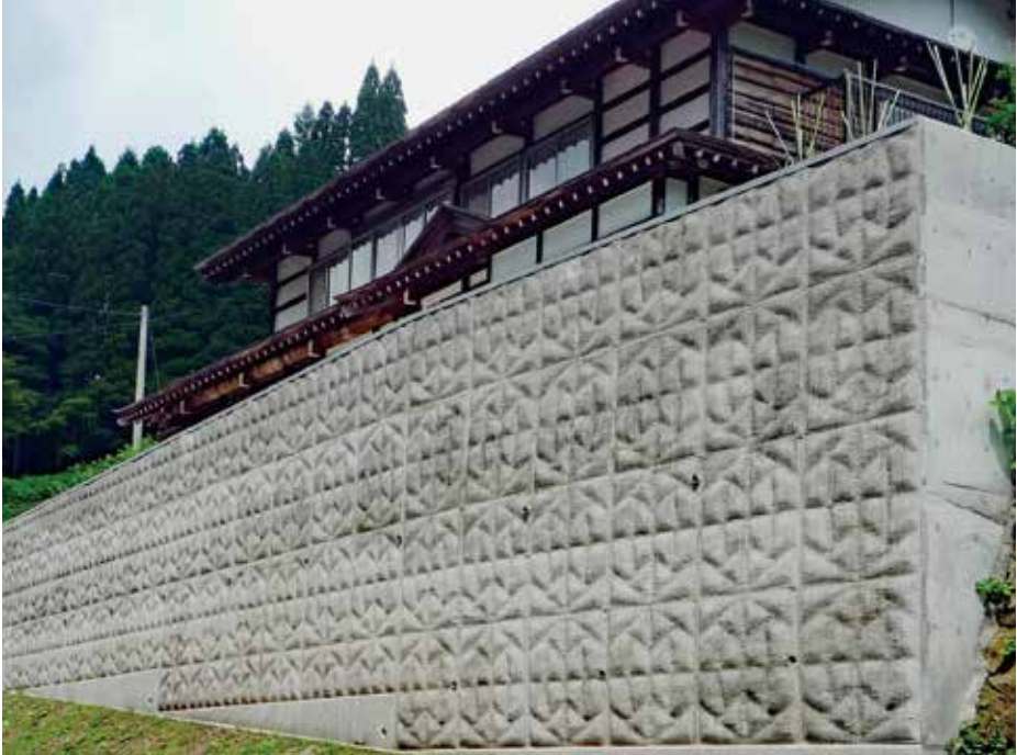
施工完了状況
