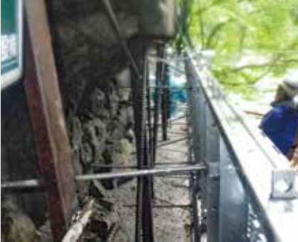
<上>組立状況 (遠景) <下>組立状況 (近景)
