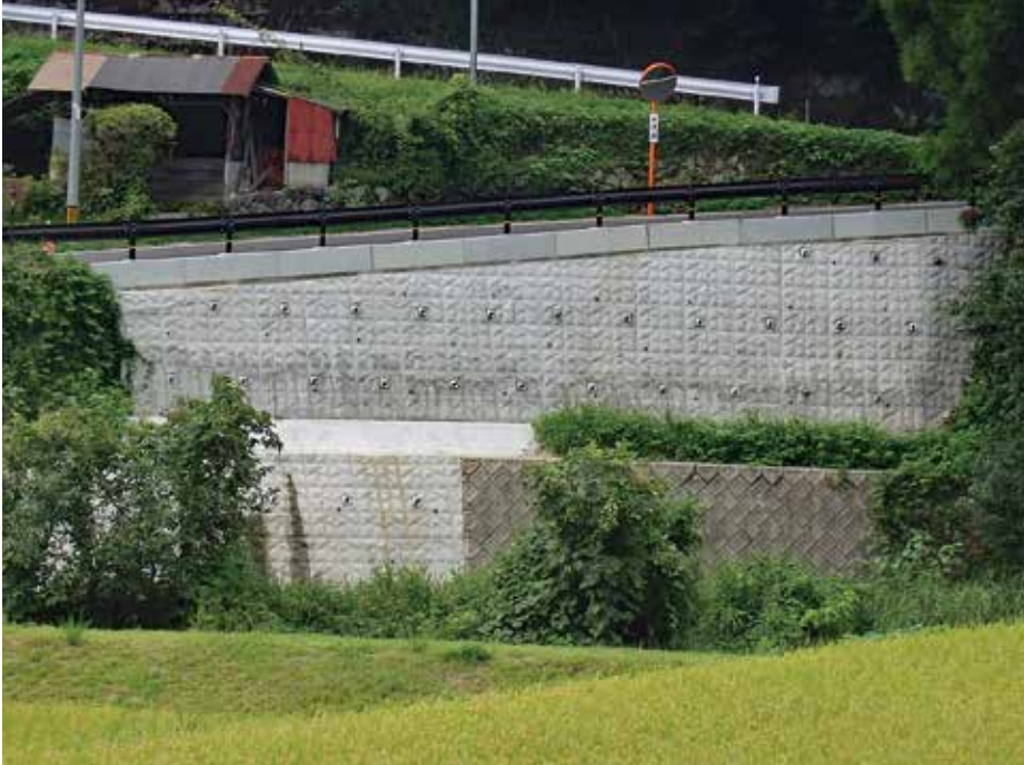
施工完了状況
