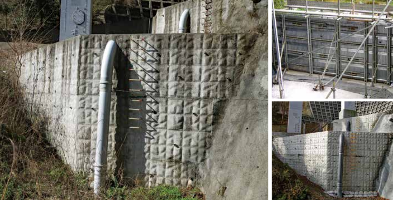
施工後9年状況
