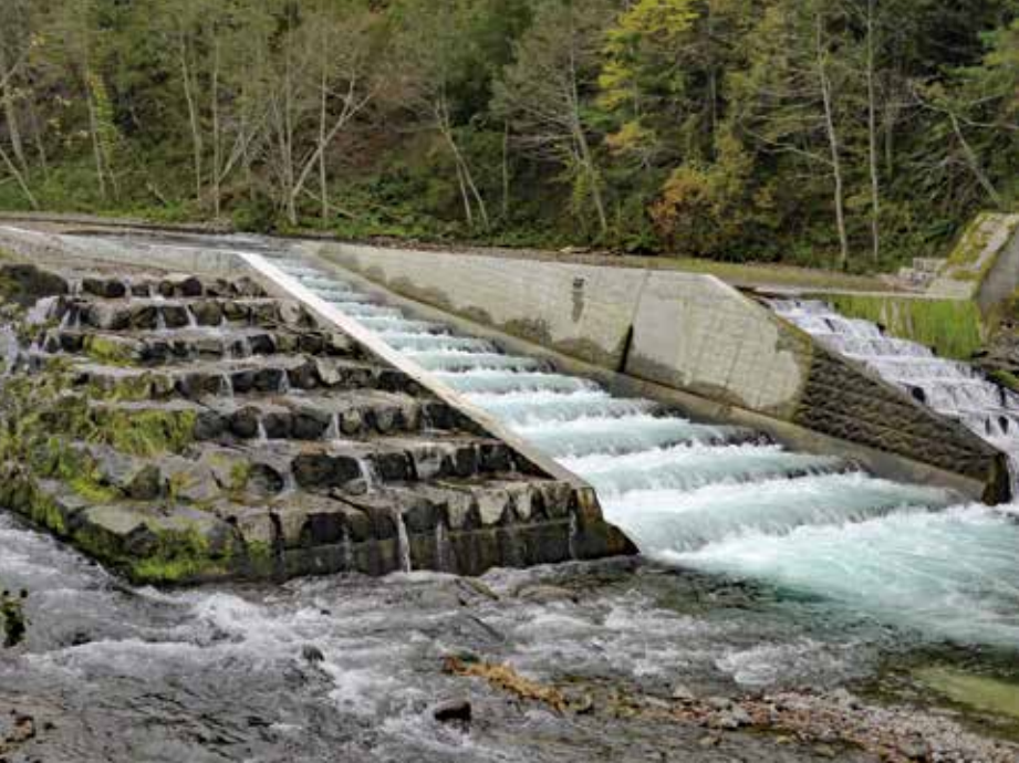
施工完了状況
