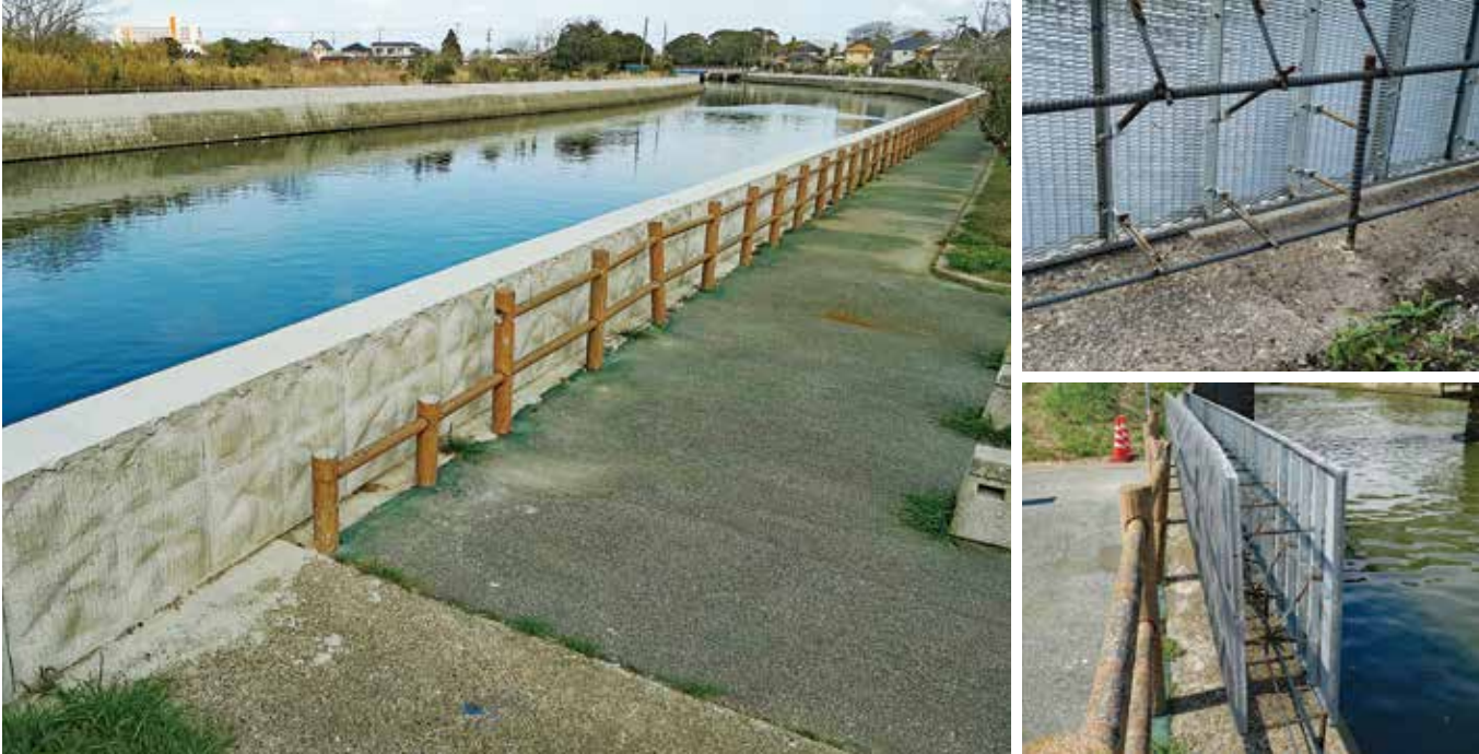
施工完了状況
