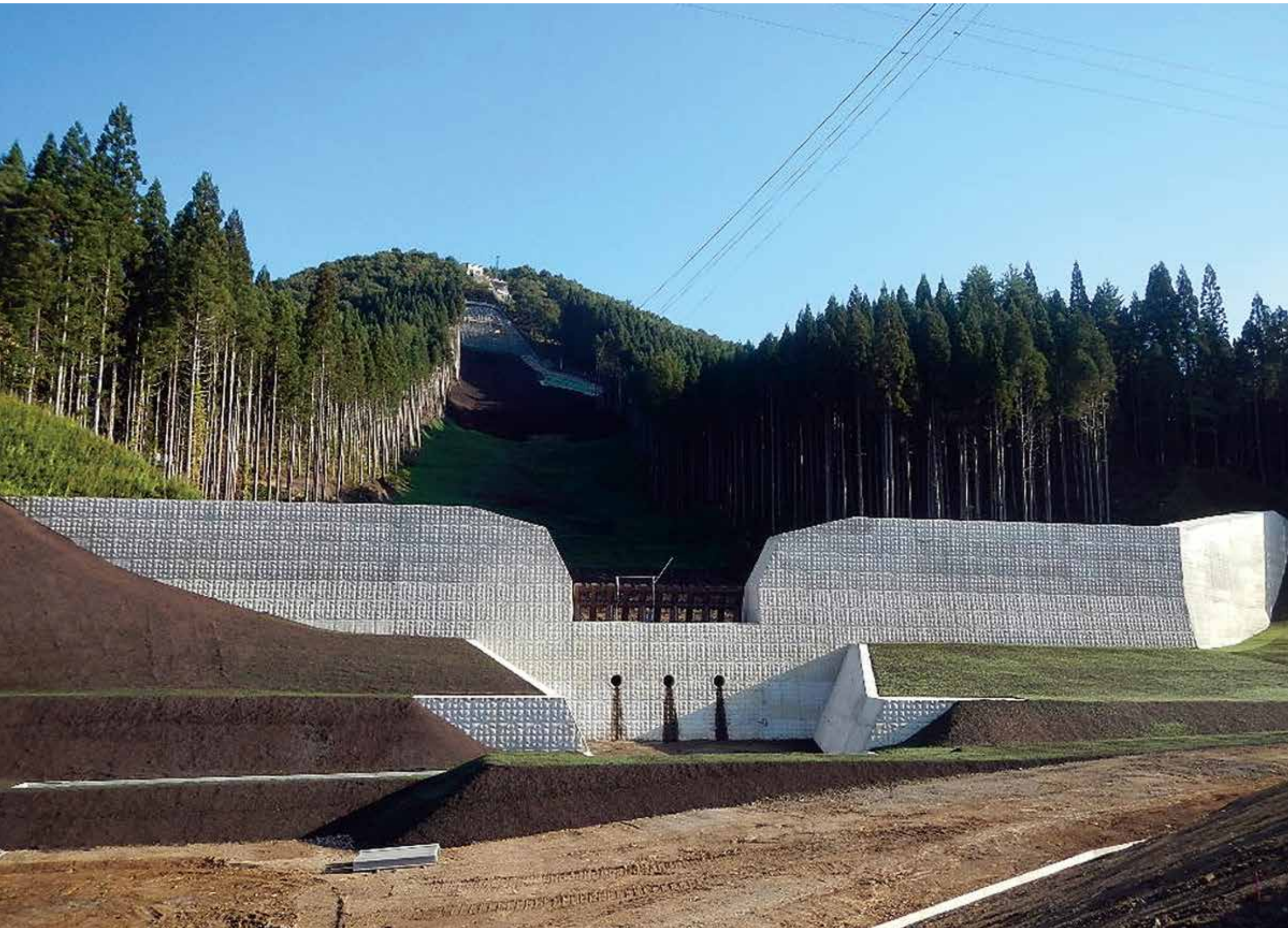
施工完了状況
