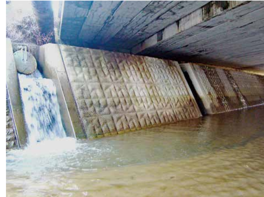
施工後3年状況
