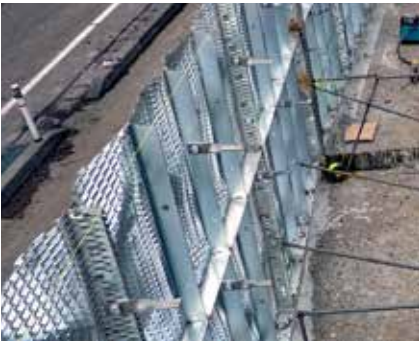
<上>施工前状況 <下>天端加工状況
