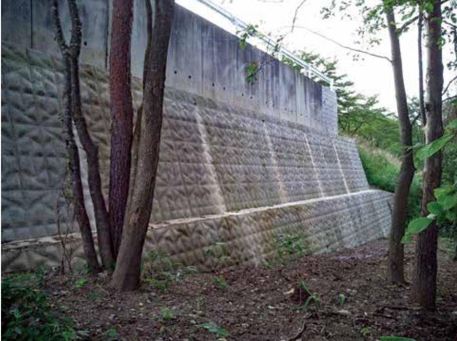
施工完了状況
