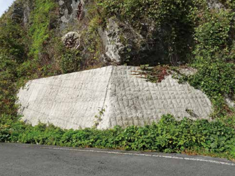
施工後5年状況
