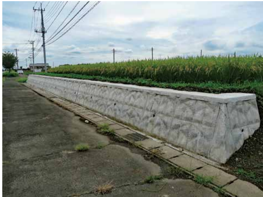
施工完了状況
