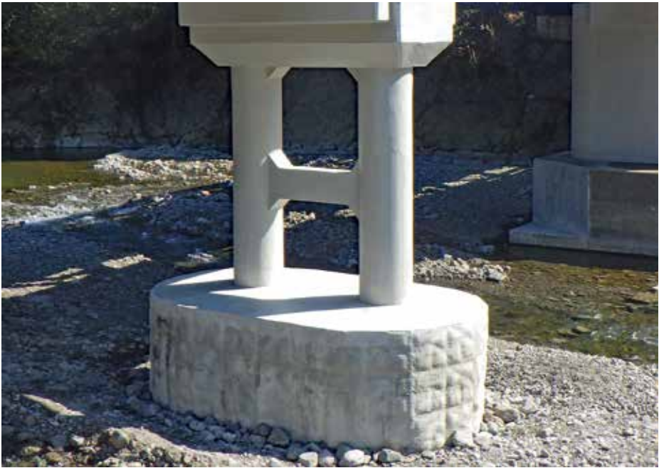
施工完了状況
