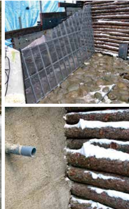
<上>組立状況 <下>端部処理状況
