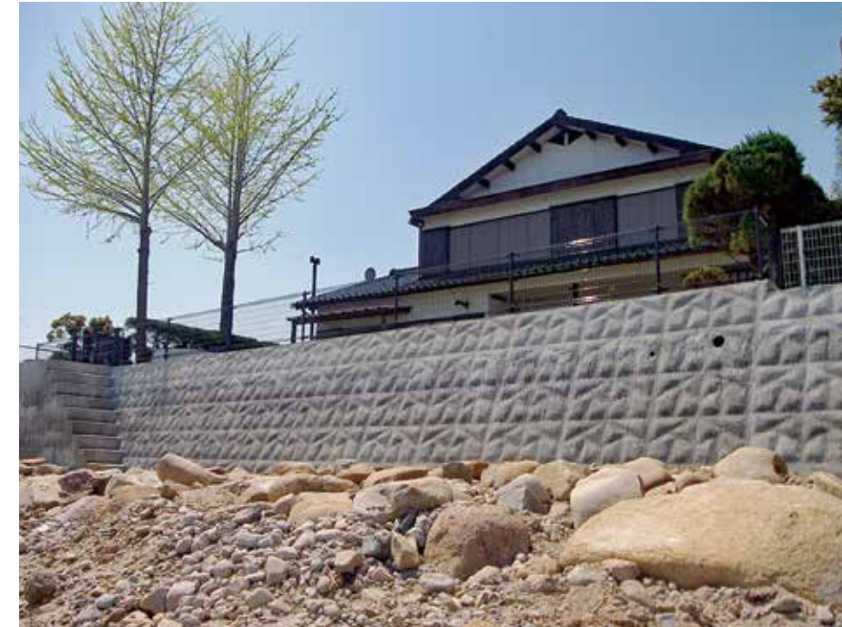
施工完了状況
