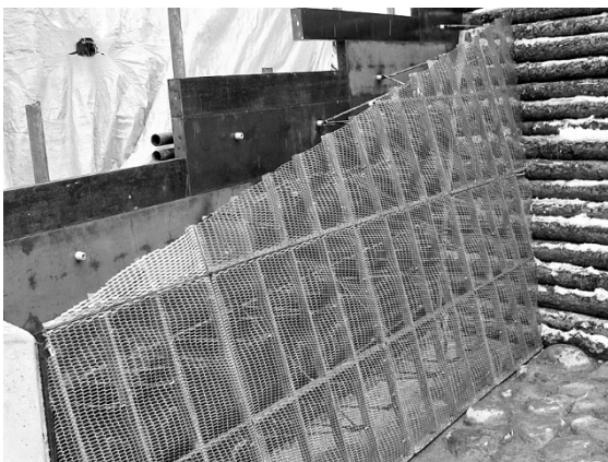
写真 23. 天端加工状況(切断)
