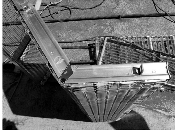
写真 32. 枠材カットによる折れ点加工例(近景)
