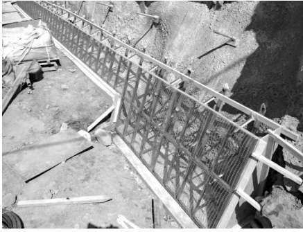
写真 37. 支保システムの固定状況例
