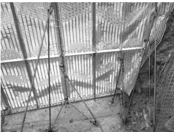
写真 27. デコメッシュ端部折り曲げ加工例
