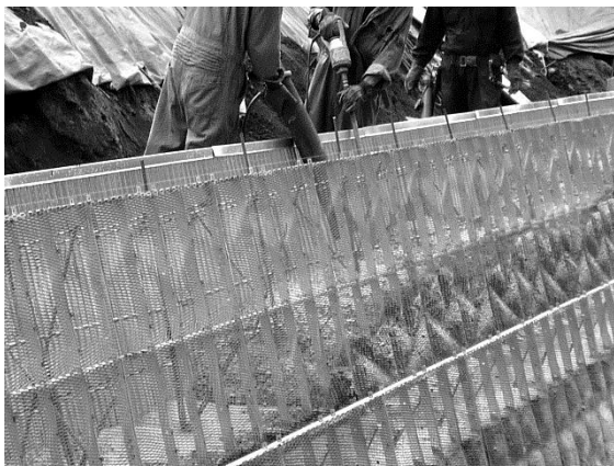
写真 20. コンクリート打設状況
