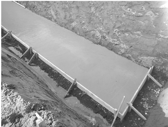
写真 7. コンクリート擁壁工基礎工の例
