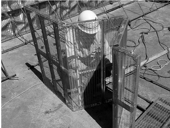
写真 31. 枠材カットによる折れ点加工例
