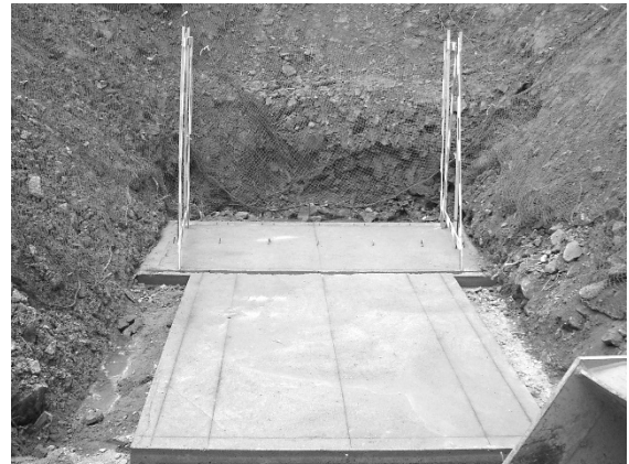
写真 8. 堰堤工基礎工の例
