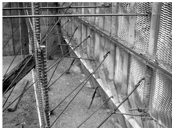
写真 34. 勾配変化点での折り曲げ加工例
