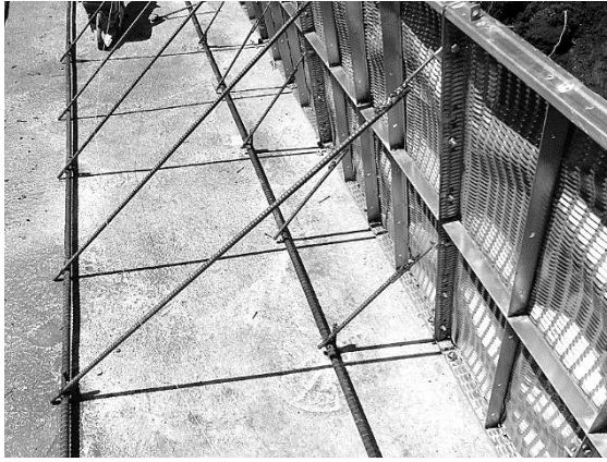
写真 16. コンクリートに設置した差し筋との固定例
