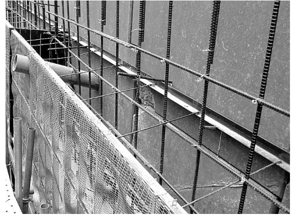
写真 17. 背面の等辺山形鋼との固定例
