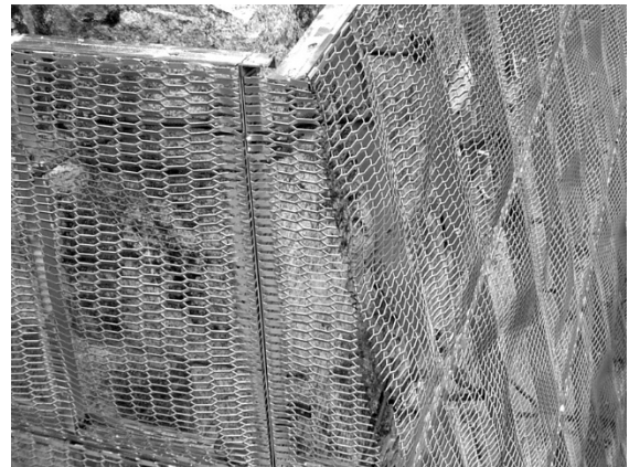
写真 28. 折れ点でのデコメッシュ加工例
