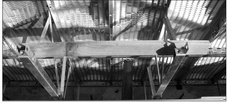
写真 38. 支保システムの固定状況例
