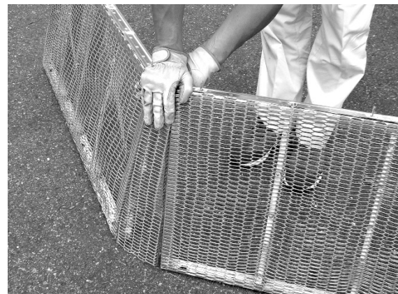
写真 30. 隙間部分への組込み状況
