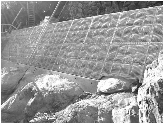
写真 18. 2 段目設置状況
