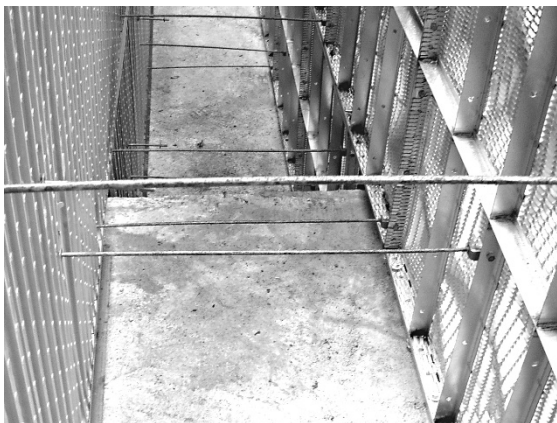
写真 14. 鋼製埋設型枠との取合い例
