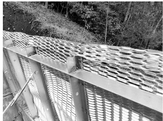
写真 24. 天端加工状況(折り曲げ)
