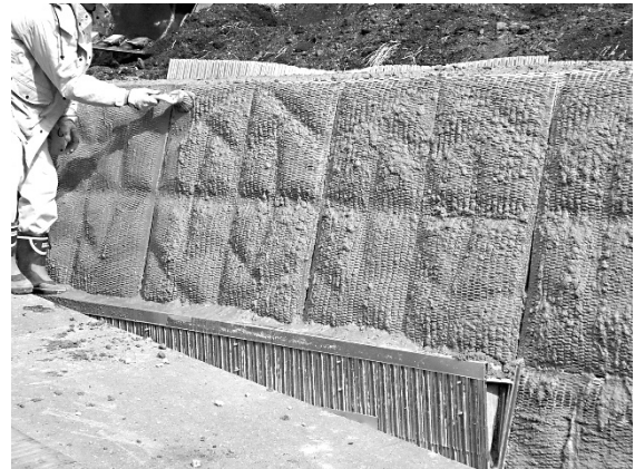
写真 22. 表面仕上げ状況
