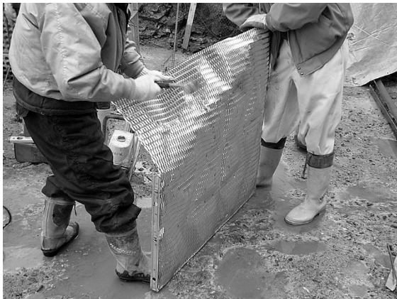
写真 25. デコメッシュ折り曲げ加工例
