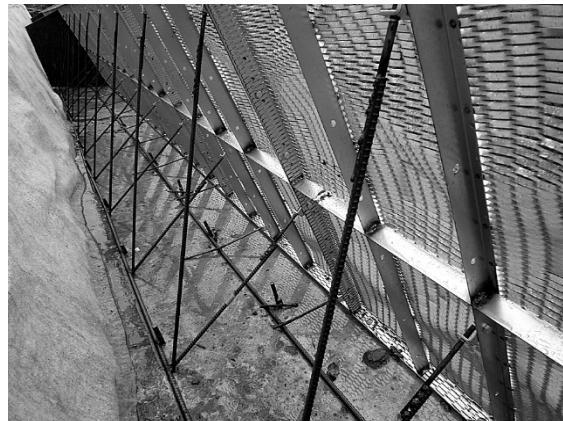
写真10. 最下段固定例（セパ取付金具追加による）
