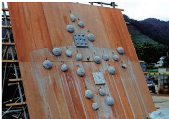
人工斜面の凹凸状況
