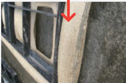
赤丸箇所接写、地山と受圧板を密着させます！
