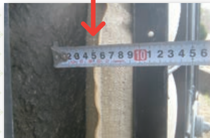
赤丸箇所接写、地山と受圧板を密着させます！
