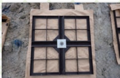
シート設置完了 (写真は田パネル DP-R1000)
