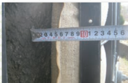
赤丸箇所接写、地山と受圧板を密着させます！
