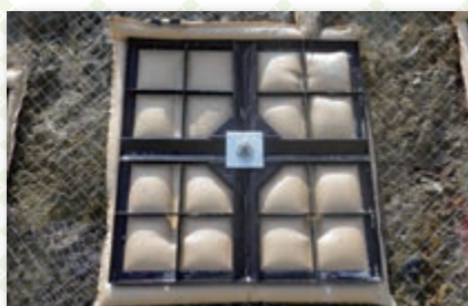
グラウト充填完了
