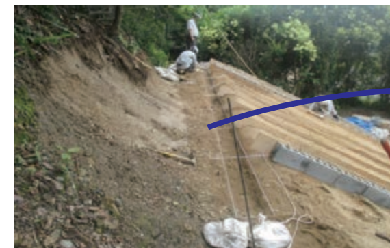
法面 小段排水溝
