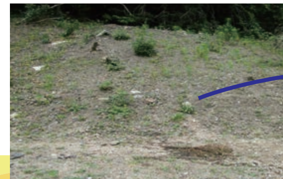
法面 縦排水溝
