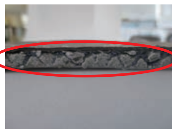
硬化後の断面状況
